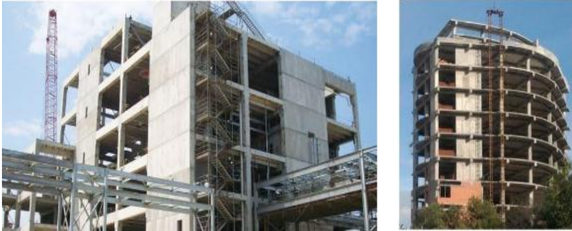
Figure I.8 : Des bâtiments avec voiles en béton armé [4]
