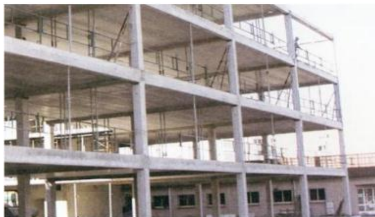
Figure I.4 : Structure contreventé par portiques [4]
