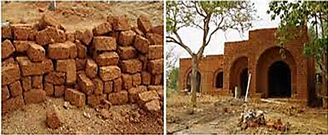
Figure.I.10 : Construction en blocs découpés, Burkina Faso [11] .
