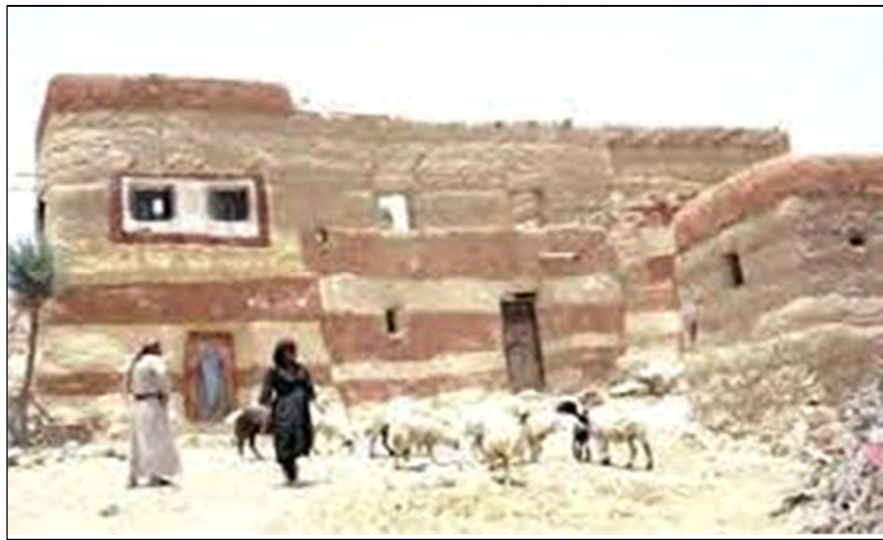
Figure.I.9 : Construction en terre empilée ; Maison à Sa'dah Yémen [11]
