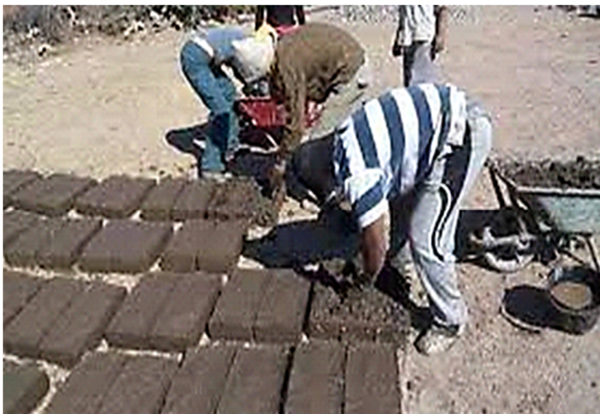
Figure.I.4. Moulage et séchage des blocs adobes[6]
