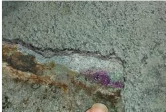
**Figure I.13 La carbonatation du béton [17]**
