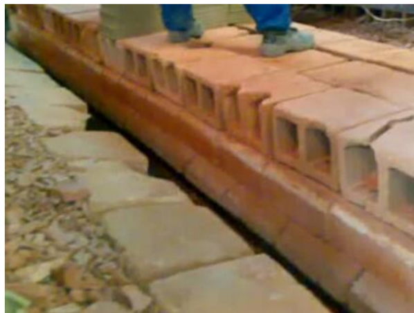
Figure III-11 : Vue latéral du four de cuisson
