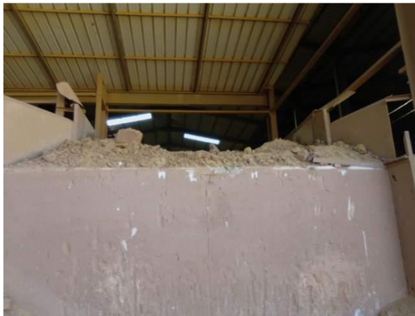
Figure III-6 : Stockage des mélanges
