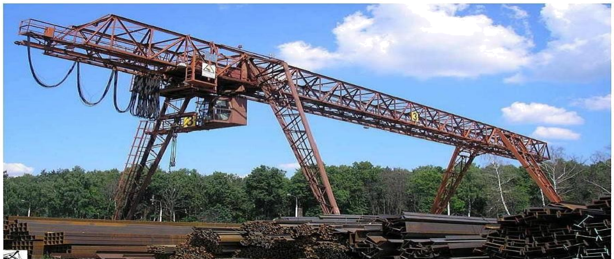
Fig. 2.2 - Travaux de la grue portique dans l'entrepôt de produits longs.
