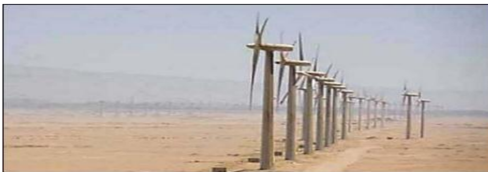
Figure 1.4: Ferme éolienne d'Adrar.
