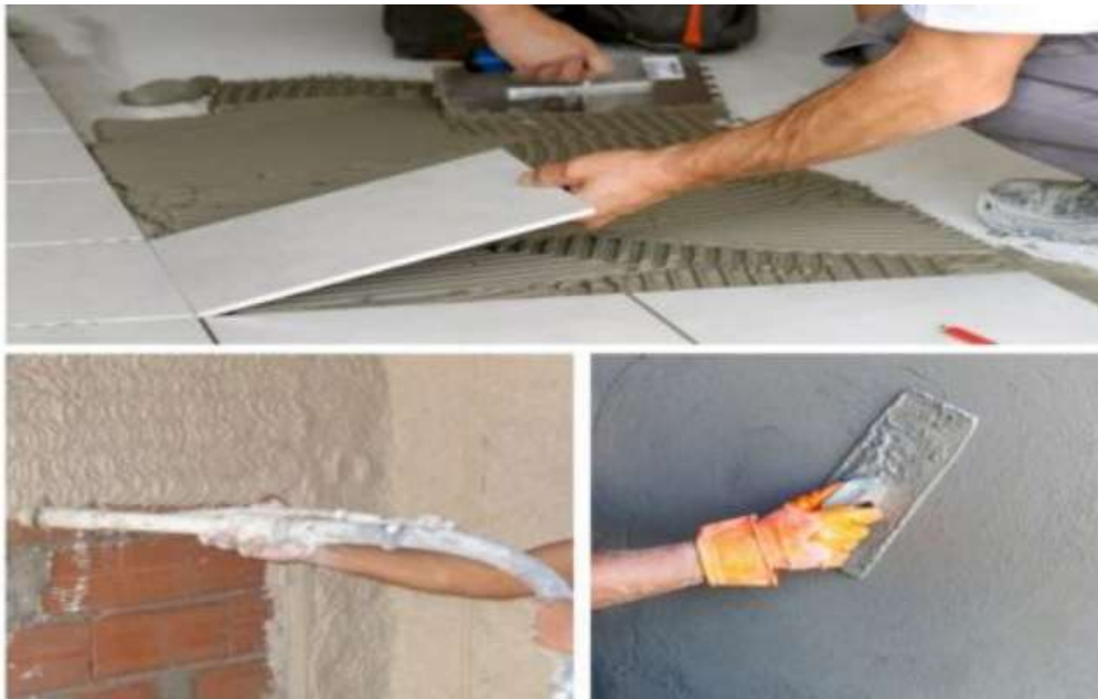
Figure I-8. Le revêtement du bâtiment.
