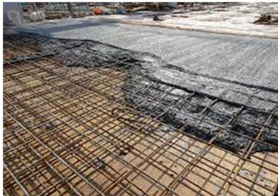
**Figure I.3 :**Exemple d'un plancher à dalle pleine
