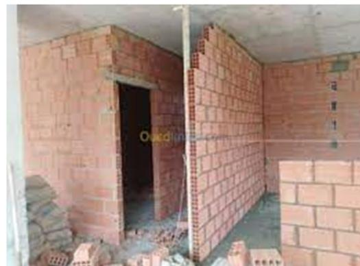
**Figure I.7.** Mur extérieurs et Mur intérieur de séparation en brique creuse.
