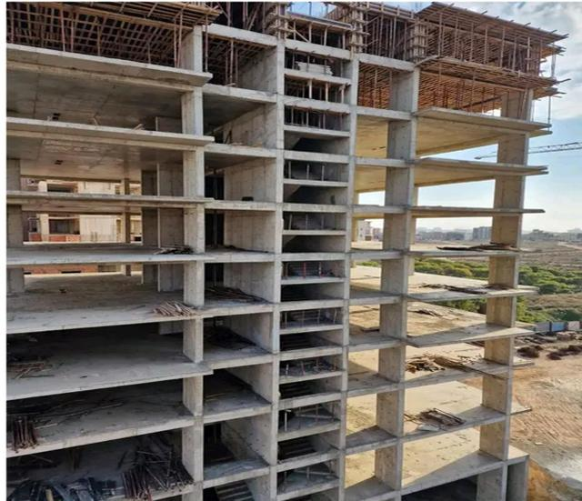
**Figure I.1 :** L'ossature en béton armé
