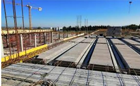
**Figure I.2 :**Exemple d'un plancher à corps creux
