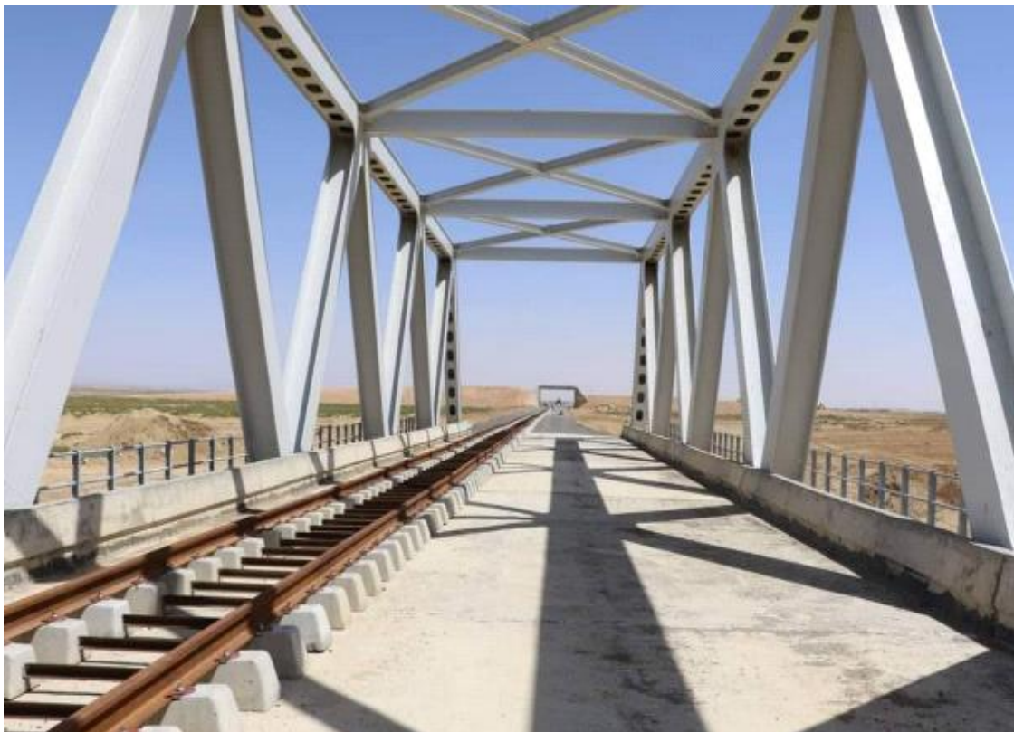
Figures IX.1 : Pont rail d'une voie unique.
