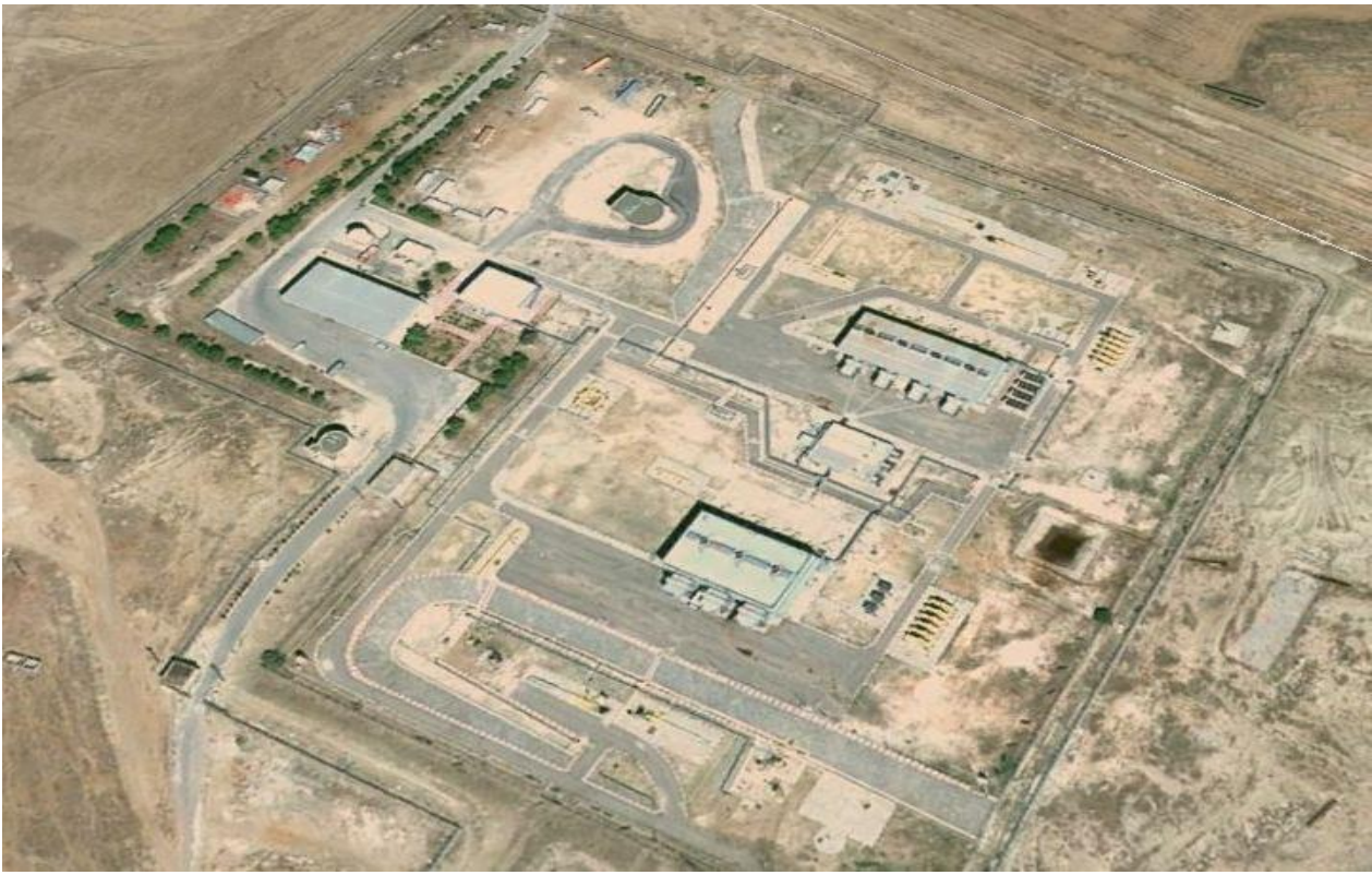
Figure III.2 : Vue aérienne de station GZ1 ; GZ2.
