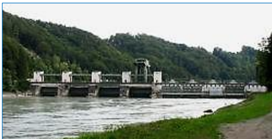
Fig I.5- Photo d'une centrale hydroélectrique en Allemagne.
