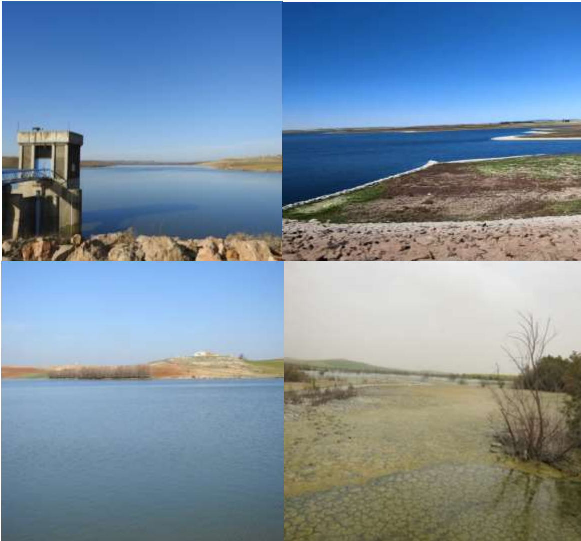
Figure 10 : Différents points d'observation cas du Barrage Dahmouni ( Photo originale )
