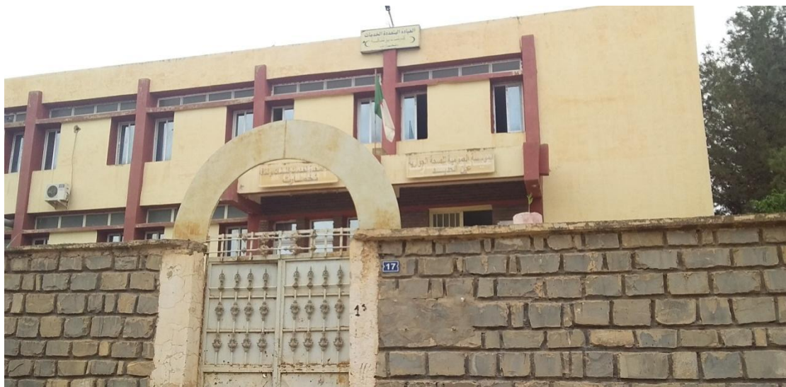
Figure 15 : L'Établissement de Public de Santé et de Proximité de Takhmert Kechichat Bouchnafa (photo originale, 2022)
