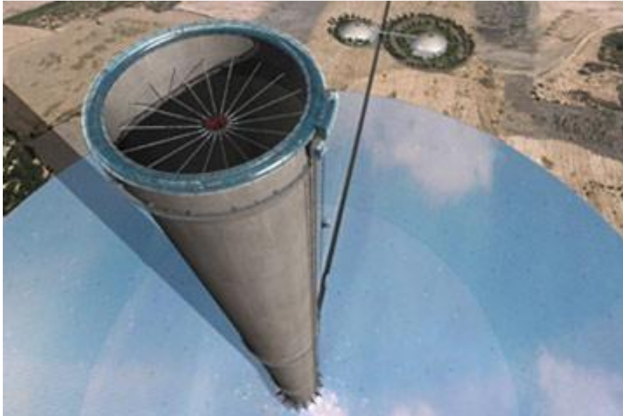
Figure (II-16): La Cheminée Solaire Australienne
