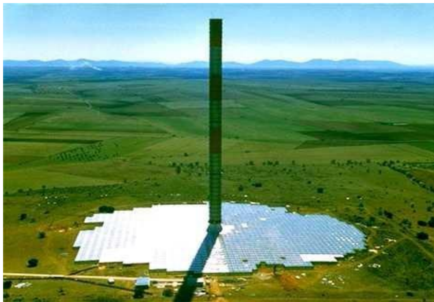
Figure II.14 La Cheminée solaire Manzanares.
