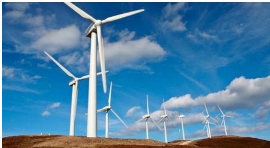
Figure I.4 une turbine Eolienne.
