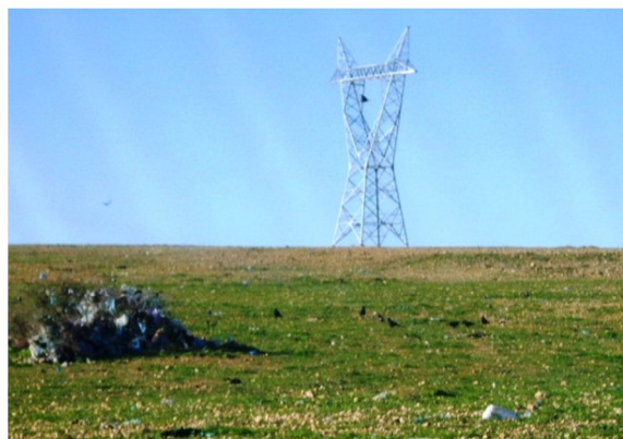
Figure 1. Grand Corbeau Corvus corax dans la décharge publique d'Oum El Bouaghi (Photo : prise par Marniche., 2008).
