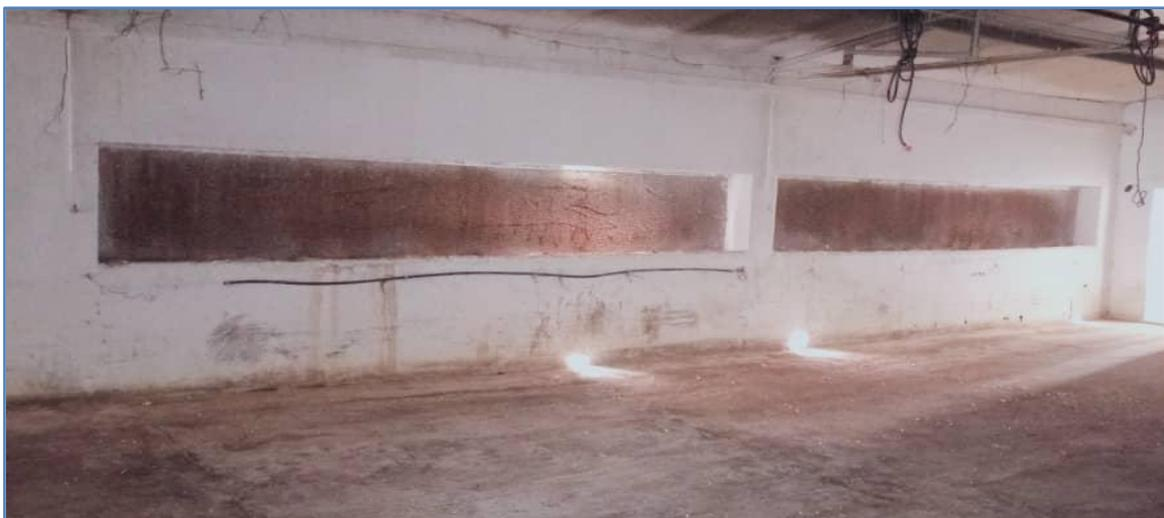
**Figure 35 :** Tampon de refroidissement du bâtiment d'élevage dinde.
