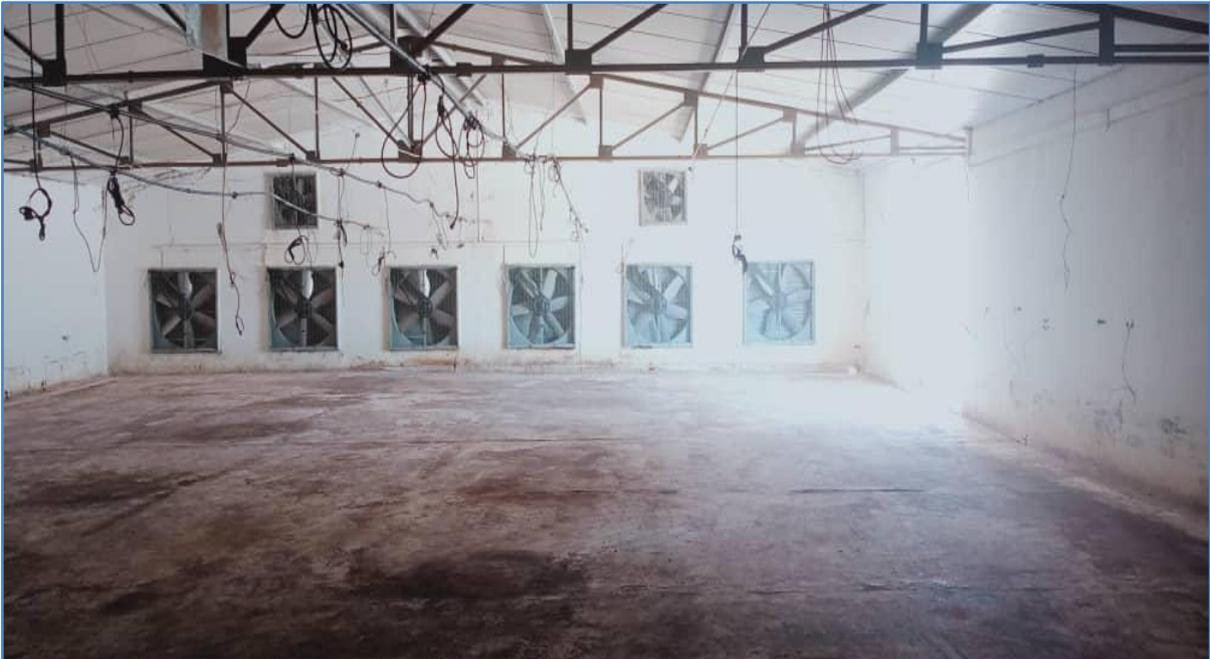
**Figure 34 :** Ventilation du bâtiment d'élevage dinde.
