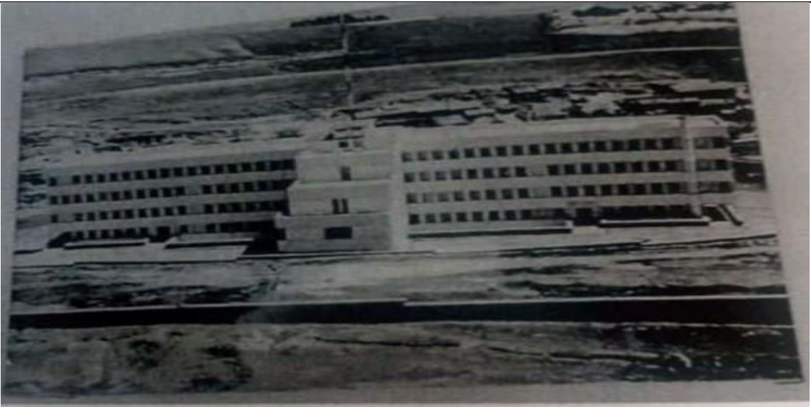
صورة رقم 05: منظر للبناية الرئيسية لمستشفى تيارت الجهوي و الحائط المحيط به أيام الانجاز
