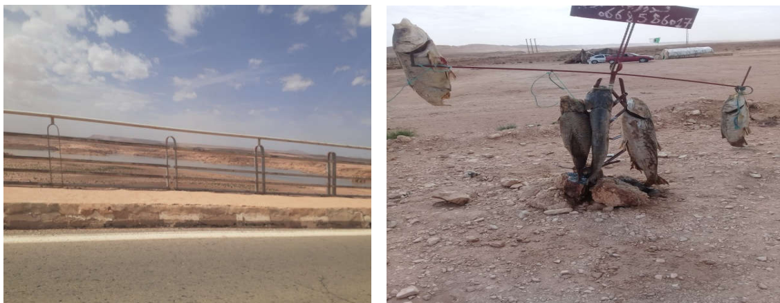
Figure 15 : Barrage de Brézina (photo prise le 12/04/2021).
