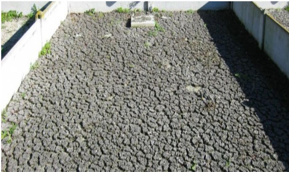
**Figure 3:** lits de séchage des boues primaires et secondaires de la STEP (Cliché, SOUDANI, 2015).
