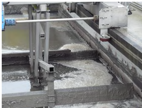
Figure I.1 : déshuileur utilisé dans l'épuration des eaux usées
