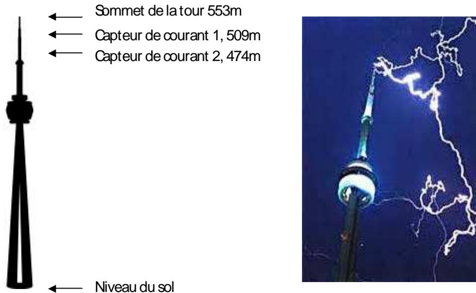
*Figure I.8 exemple de mesure de courant de foudre en utilisant une tour instrumentée. Tour CN à Toronto au Canada [9].*
