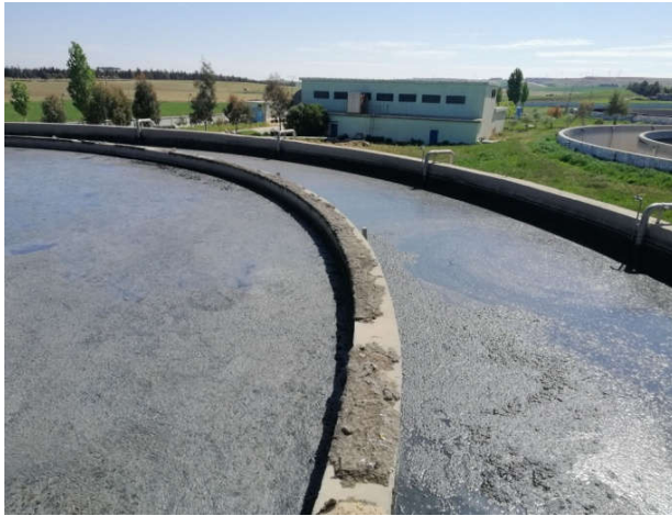
Figure 07 : Photo du bassin de décantation de la STEP de la ville de Tiaret (Photo originale, 2021).
