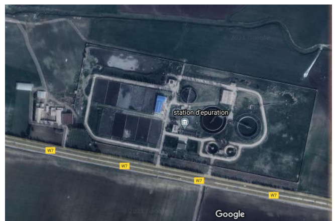
Figure 02: Vue aérienne de la STEP de Tiaret.
