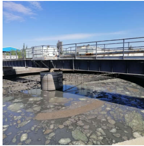
Figure 04 : Photo du digesteur aérobie de STEP de la ville de Tiaret (Photo originale, 2021).
