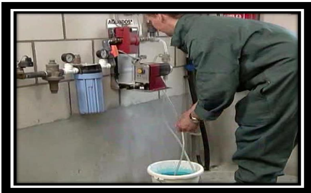
Figure16: Introduction de vaccin dans le système de distribution d'eau de boisson coloré
