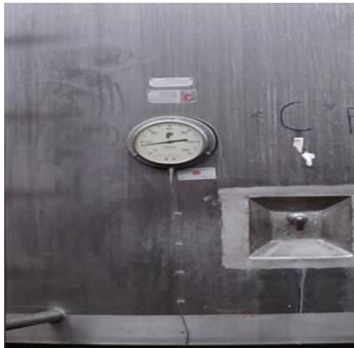
Figure N° 20: Réglage du tank.
