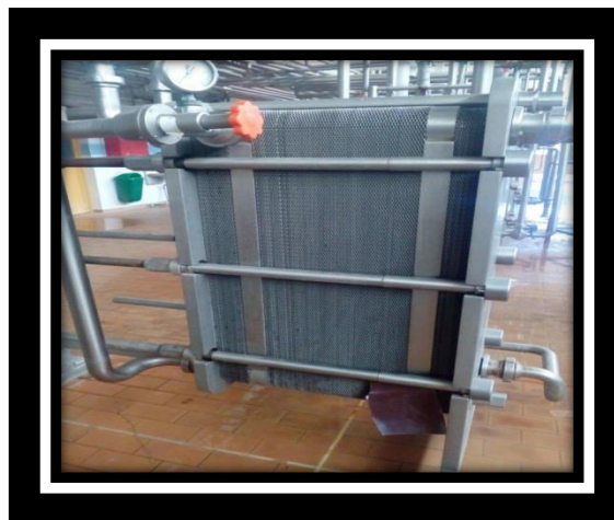
Figure N° 02 : Echangeur à plaque du pasteurisateur.
