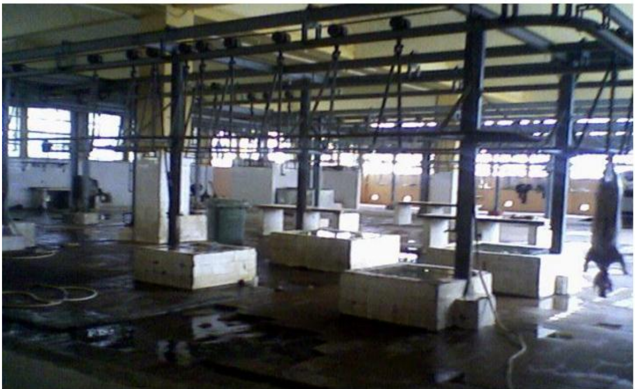
Figure n 15: L'intérieur de l'abattoir de Tiaret
