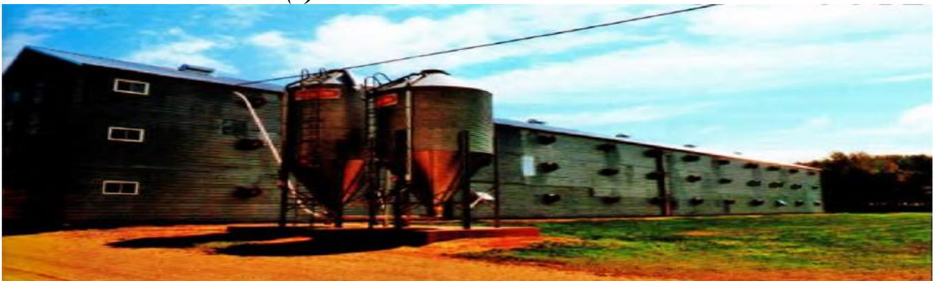
*Photo1.8* Dans certaines régions (ici au Québec), des poulaillers a plusieurs étages permettent de limiter les pertes thermiques pendant les saisons froides.
