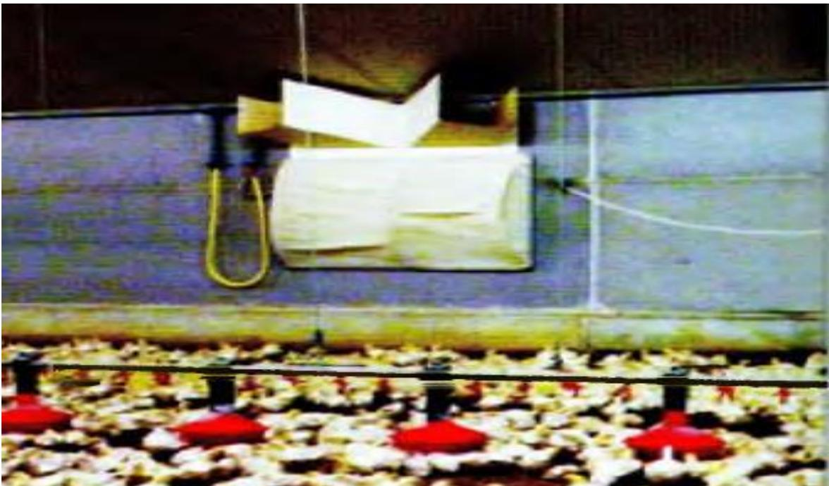
*Photo 1.9 Les échangeurs d'air permettent de réaliser des économies substantielles d'énergie et de mieux maîtriser l'hygrométrie dans les bâtiments.*
