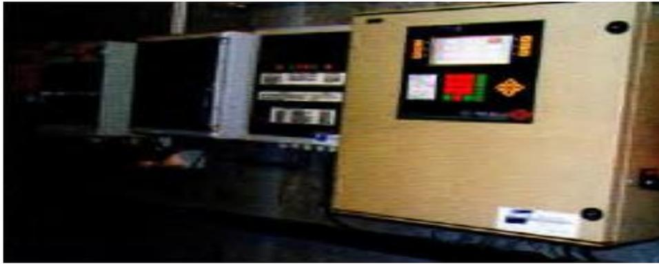
*Photo 1.6* La maîtrise de l’ambiance dans les bâtiments avicoles est pilotée par des boîtiers de régulation de plus en plus sophistiqués
