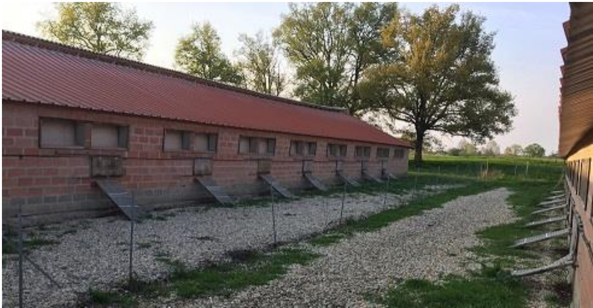
Figure 12 : Photographie de l'extérieur d'un bâtiment de ponte « plein-air » (C. Misslin)
