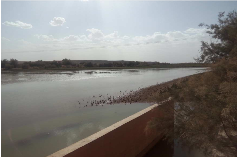
Figure 15 : Barrage d'Abadla (Photos Sellaoui, 2018)
