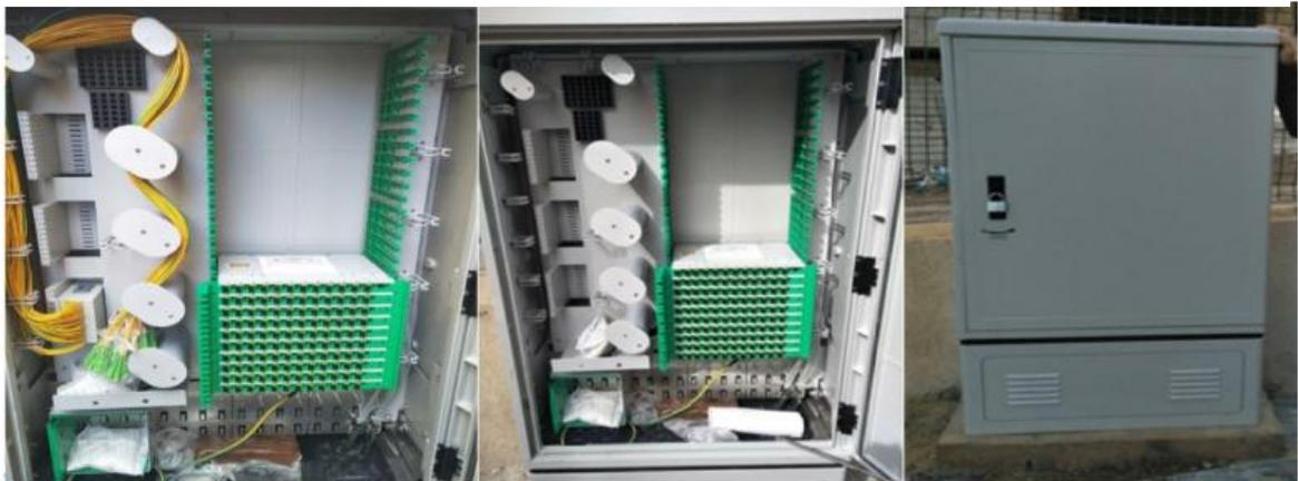
Figure 27: SRO (Intérieur et extérieur)
