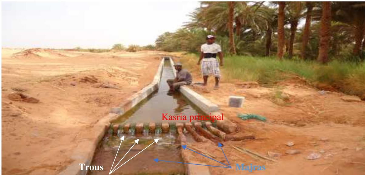
Figure N°31 : Kasria principale à la sortie de la foggara sahel
