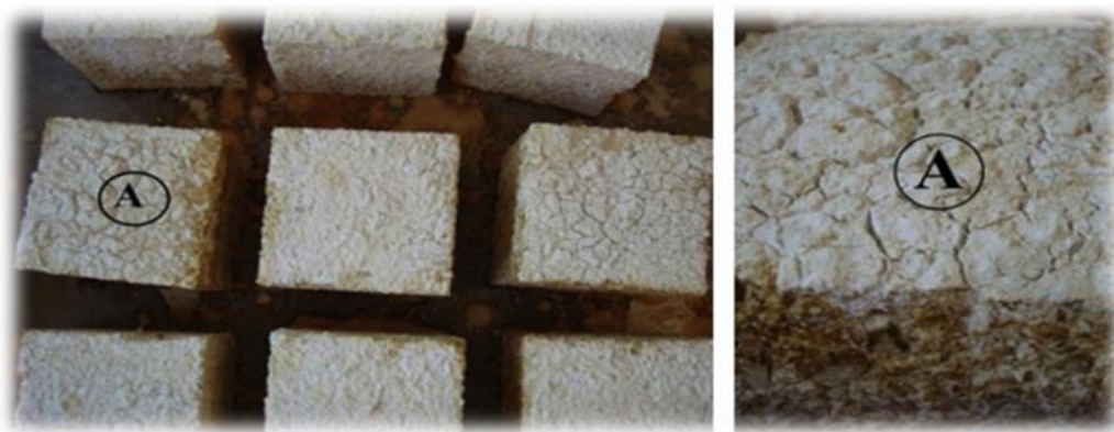
Figure I.4 : Exemple de l'attaque par l'acide sulfurique dosé à 5% pour un béton ordinaire durant quatre mois [6]
