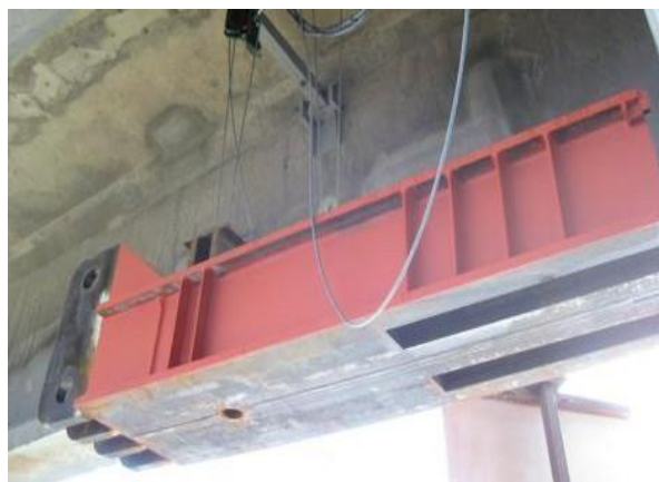
Figure III.4 : Renforcement par Tissus en Fibres de Carbone TFC d'une poutre en acier [76]
