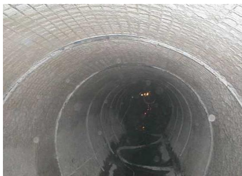
Figure I.11 : ouvrage renforcé par béton projeté [23]
