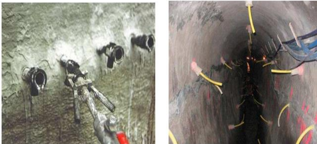
Figure I.10 : mise en place des canules d'injections [22].
