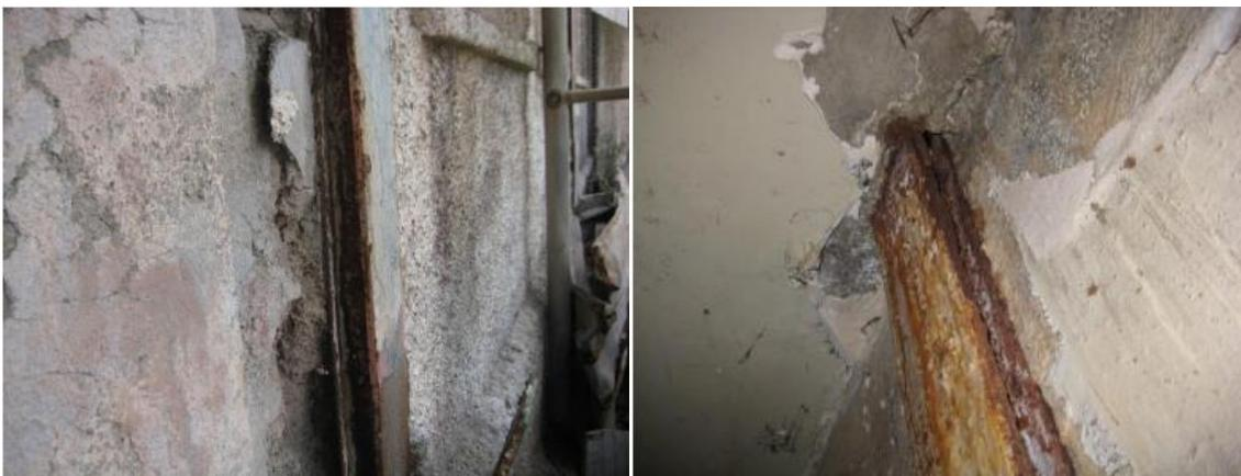
*Figure I.1 : Corrosion de poteaux métallique [1]*
