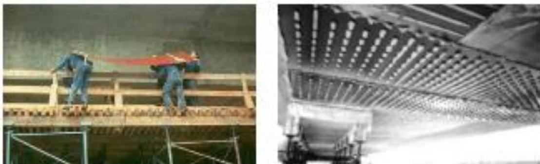
***Figure. II.10 : Tôles collées ; (a) difficulté de manutention ; (b) Renforcement du viaduc de Terrenoire par tôles collées perforées -Brevet Freyssinet [58]***
