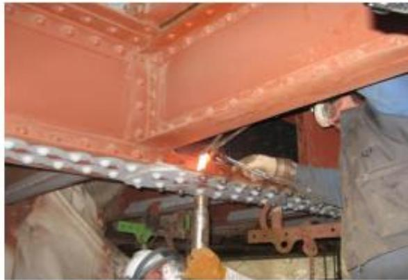
*Figure II.5 : Pose d'un rivet à tête ronde et gougeage de la tête de rivet. [9]*
