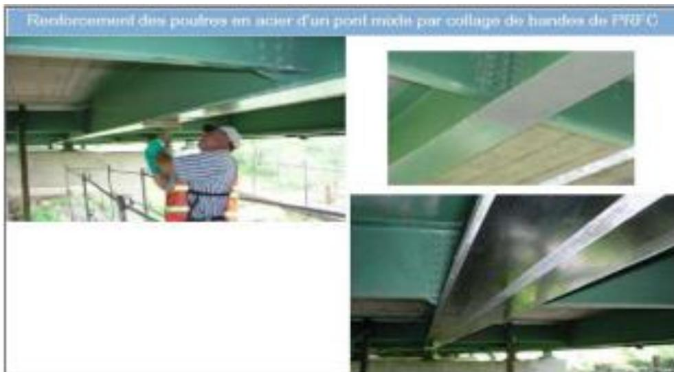
*Figure II.11: Différentes méthodes de renforcement par le collage de plaques en composites. [49].*
