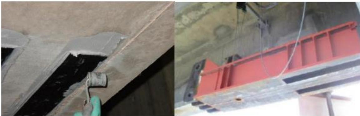
*Figure II.13 : Renforcements des structures par des plaques en FRP [10].*
