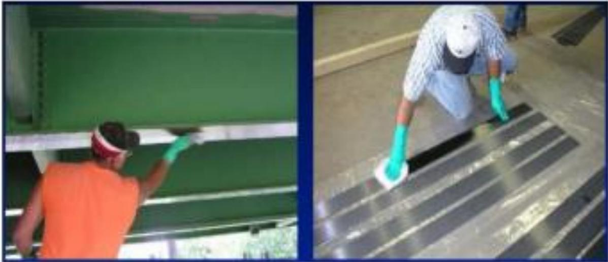
✚ Préparation de la surface (nettoyage de la surface de collage avec Acétone)
