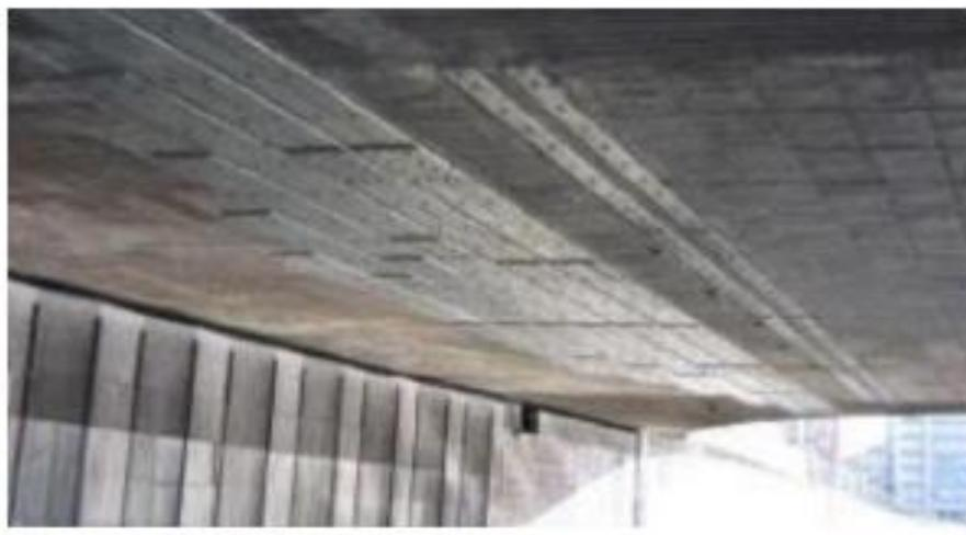
***Figure II.9 : Renforcement par plats métalliques [11]***
