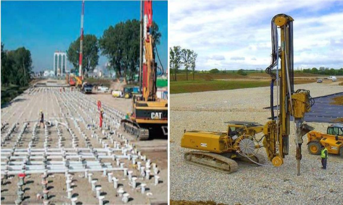
**Figure 1.4:** Installation des drains.
