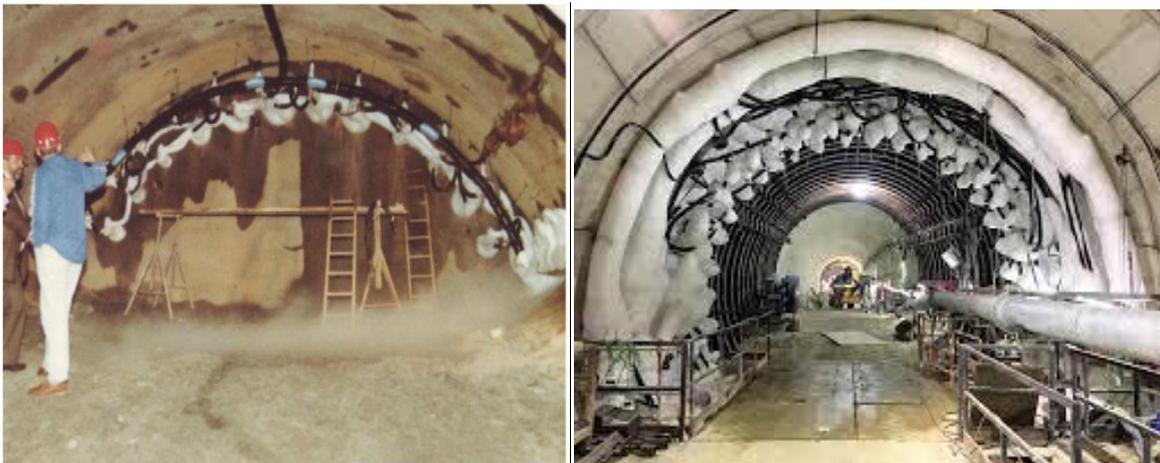
**Figure 1.6:** Traitement par congélation sous bâtiment pour tunnel de métro.
