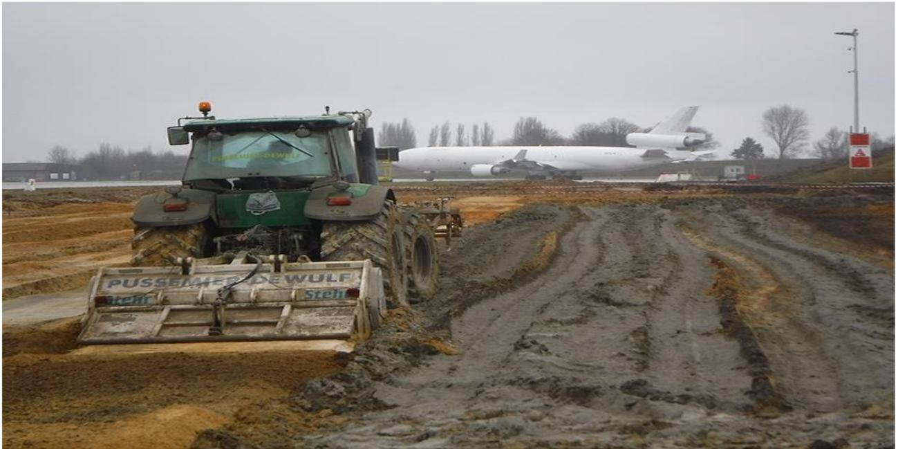
**Figure 1.7:** Chantier de traitement du sol au ciment.
