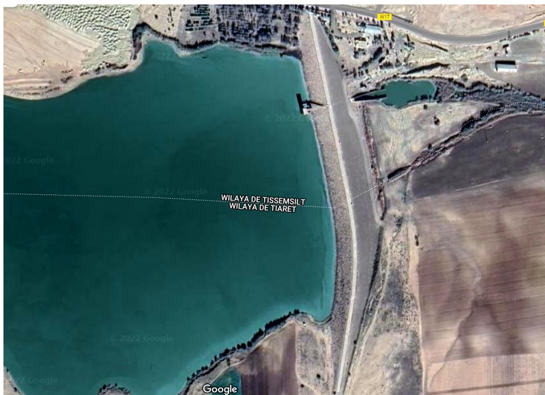
Photo IV.2 Digue du Barrage Col. Bougara
