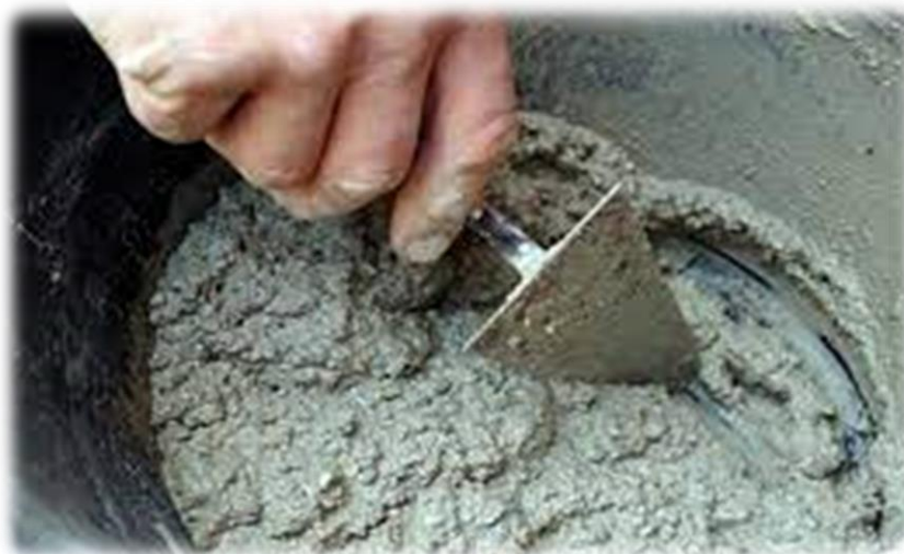
Figure 1.1. Mélange de mortier [1]
