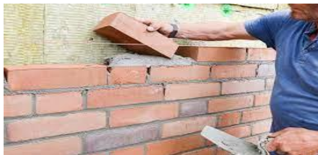
Figure 1.8. Les joints maçonneries [14]
