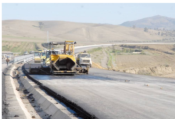
Figure 1 : Construction de l'autoroute Est-Ouest www.algerie-eco.com consulté le Mai 2020
