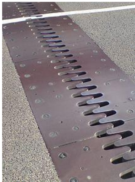
FigureVIII.3 : joint de chaussée
