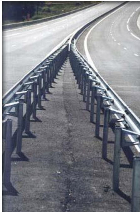
FigureVIII.5 : Glissière métallique souple autoroutière
