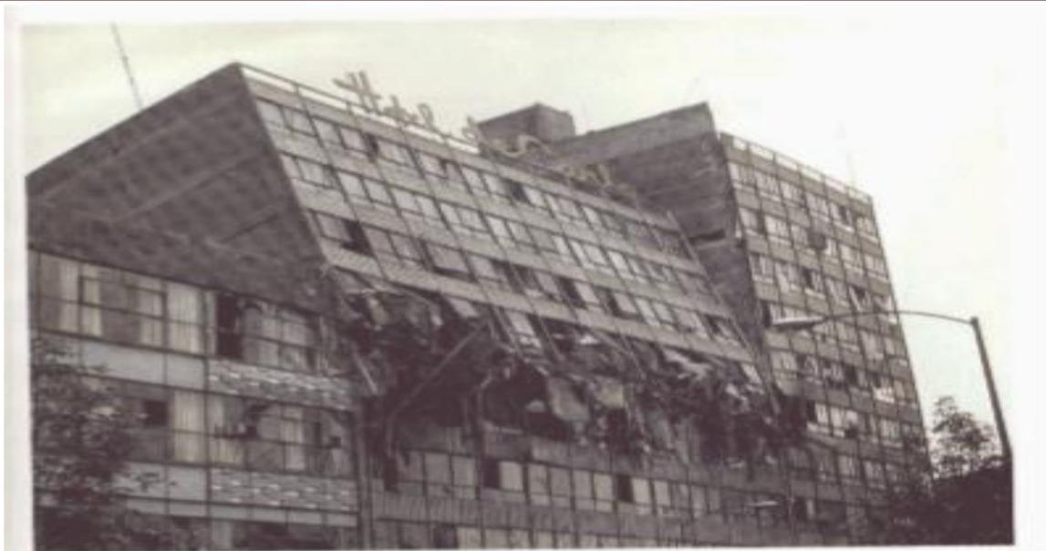
**Exemple de dommage dû à l'irrégularité en élévation.** Variation des géométries.
