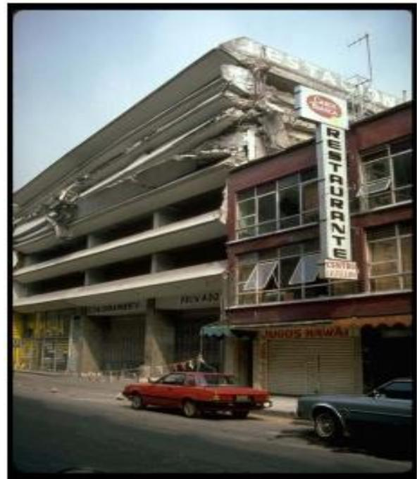
Le problème particulier des constructions sur pilotis est illustré par le cliché ci-dessous. Dans ce cas, contrairement à l'exemple ci-dessus, c'est le bas de la construction qui est plus flexible, ce qui sollicite de façon trop importante les têtes de poteaux, sous l'effet forces d'inertie des étages supérieurs peu déformables.
