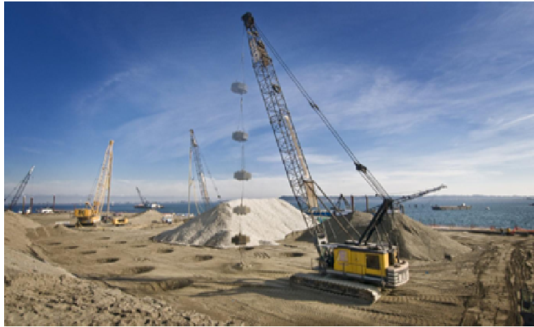
Figure 2.7: Chantier d'un compactage dynamique profond
