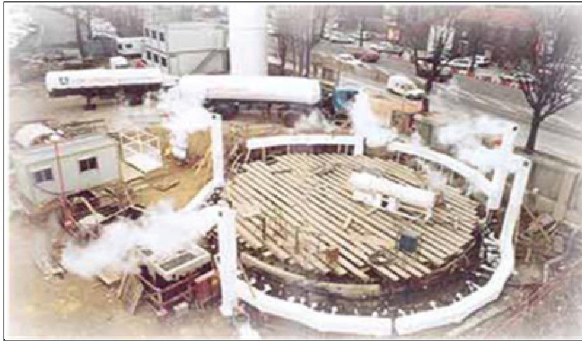
Figure 2.11: Chantier utilisant la congélation du sol
