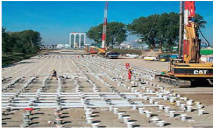
Figure 2.10: Procédé d'installation des drains
