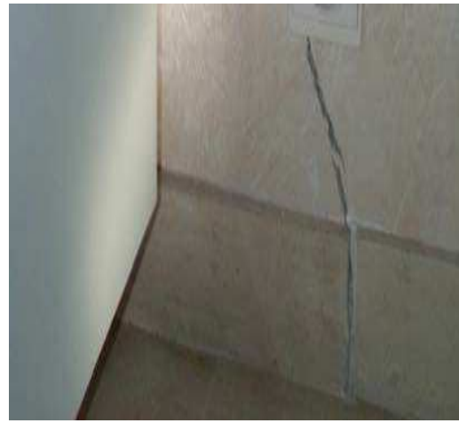
Figure 1.3: Désordres de la structure au cours des périodes de la sécheresse (Région bordelaise)
