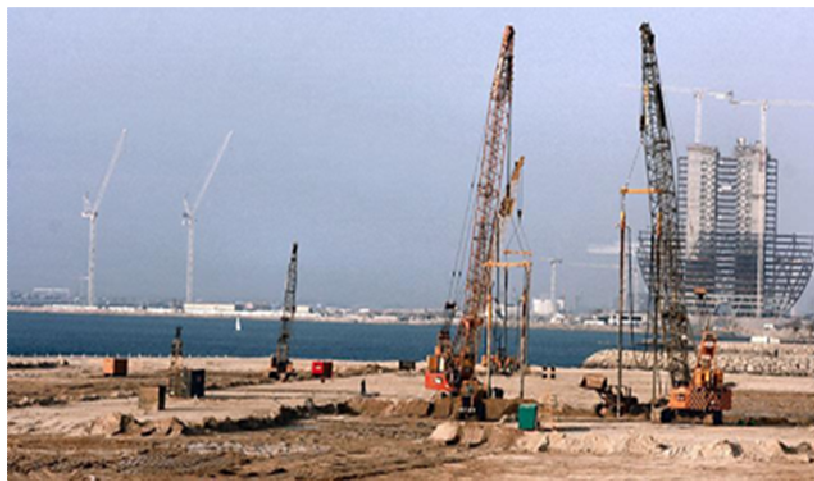
Figure 2.8: Procédé du vibrocompactage
