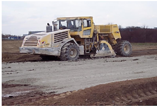
Figure 2.13: Chantier de traitement du sol au ciment
