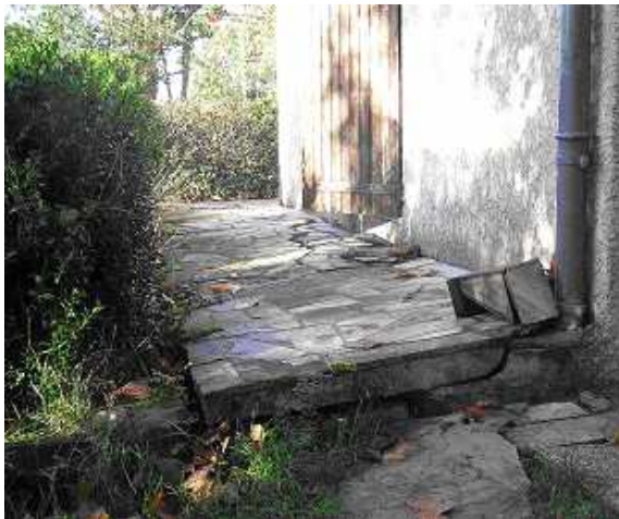
Figure 1.3: Désordres de la structure au cours des périodes de la sécheresse (Région bordelaise)
