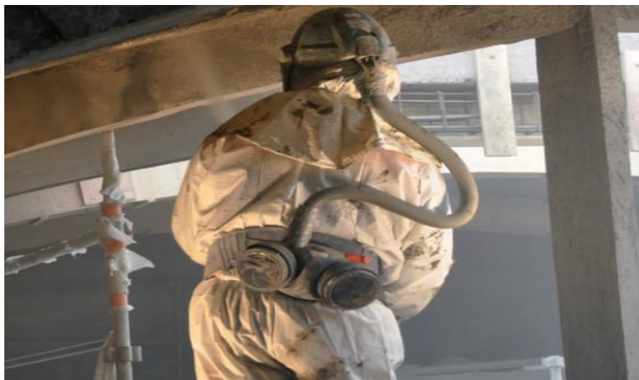
Figure II. 5 : Renforcement au moyen de béton projeté.
