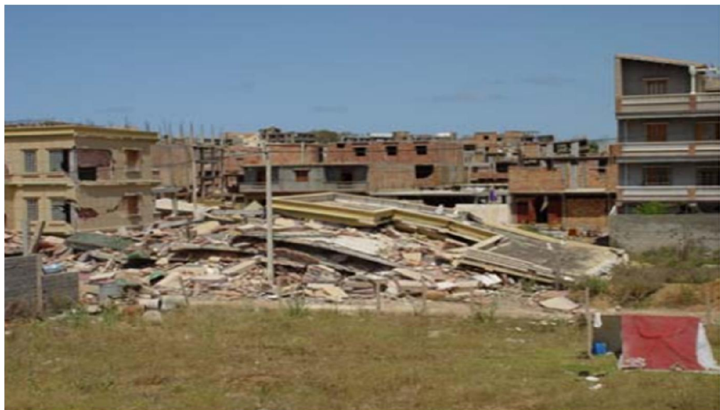
Figure I.26 : Effondrement total d'un bâtiment de 3 étages à cause Du manque de la stabilisation latérale.
