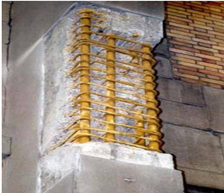
Figure II. 4 : Réfection du béton et protection des armatures.
