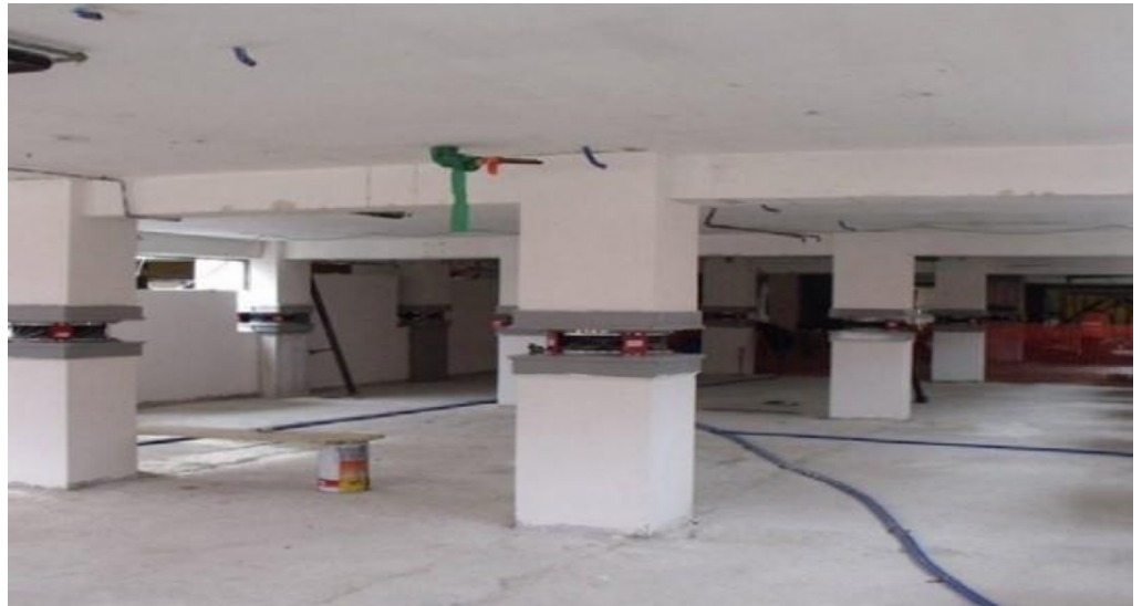
Figure II. 7 : Représentation de l'isolation sismique
