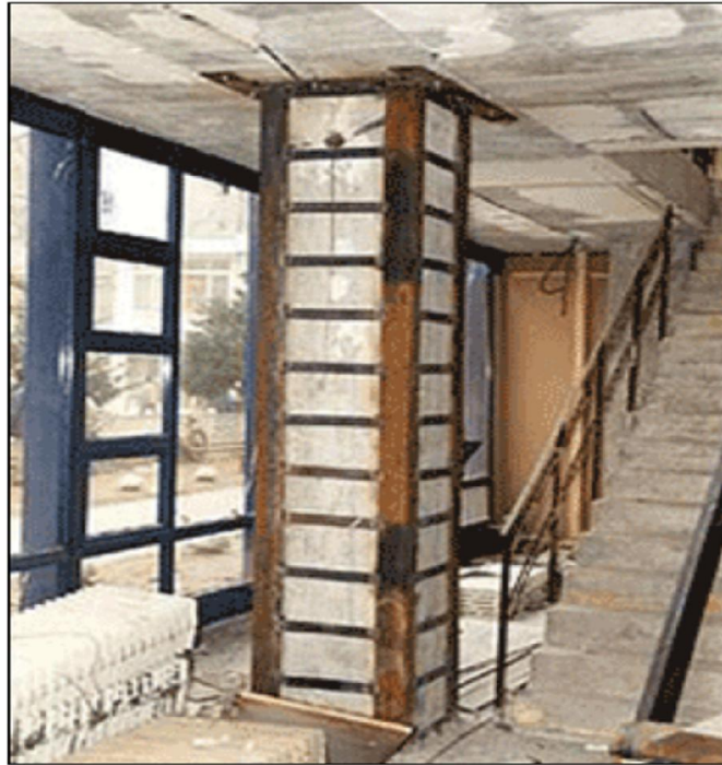
Figure II. 13 : Gainage métallique d'un poteau en béton armé
