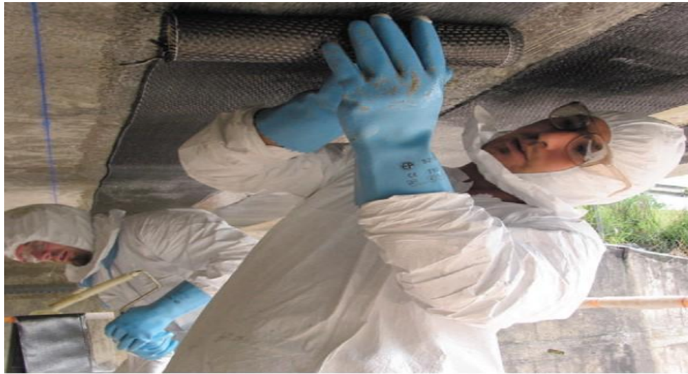
Figure II. 11 : Renforts par plaques composites
