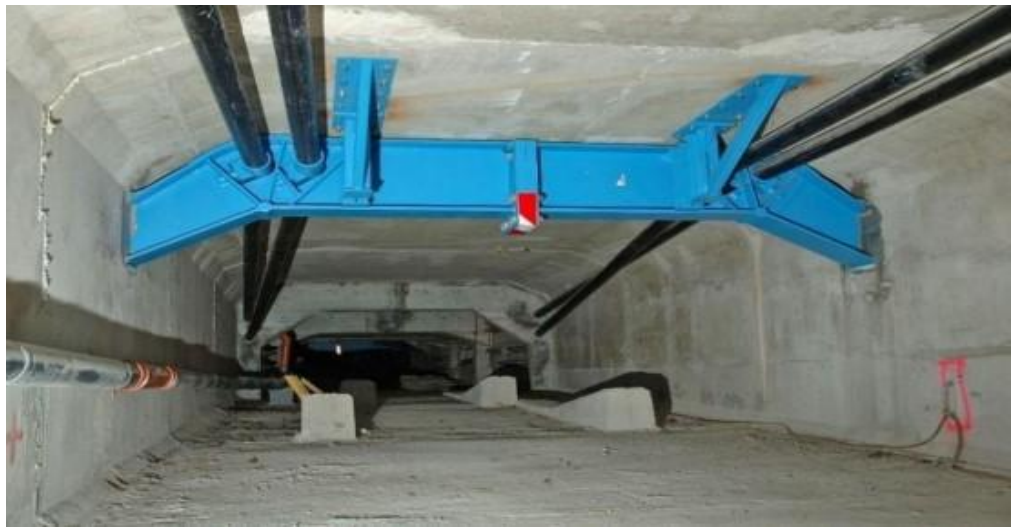
Figure II. 10 : Précontrainte additionnelle
