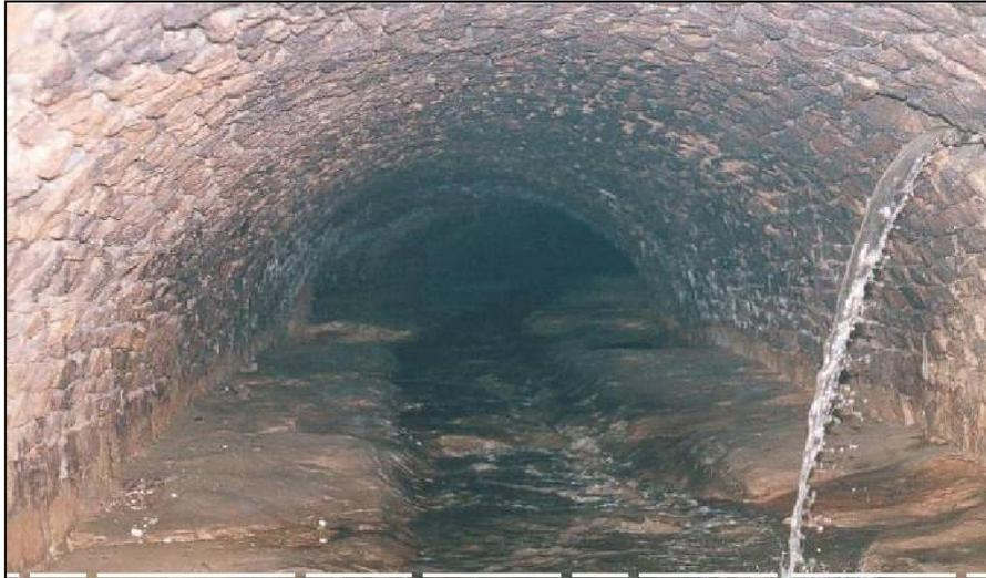
**Figure IV.1 :** Canal en moellons avec toiture en voûte- Erosion importante du lit
