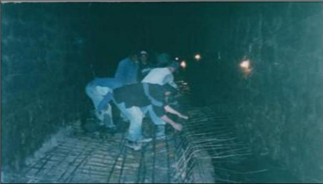
**Figure IV.14** : Ferrailage du radier
