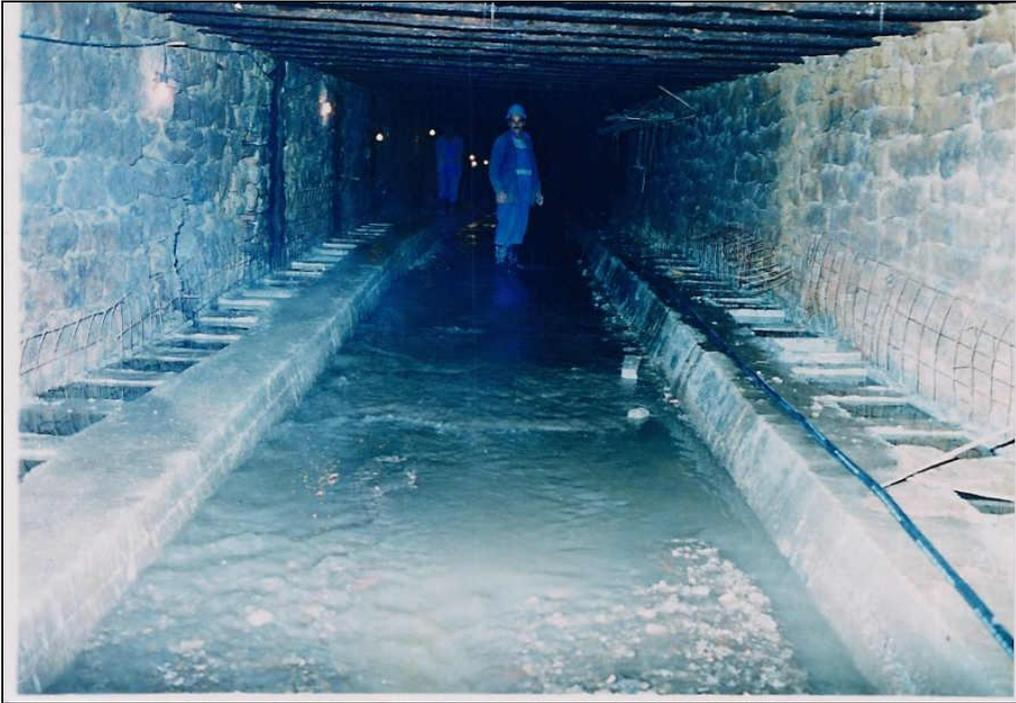
**Figure IV.16 :** Radier réalisé pour une section rectangulaire
