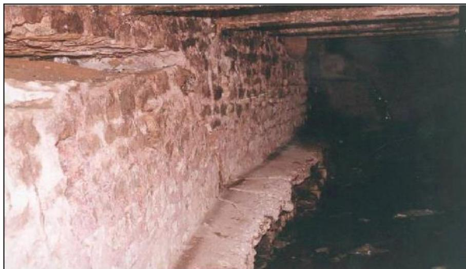
**Figure IV.3 :** Instabilité générale de la structure- Ecoulements sous voiles
