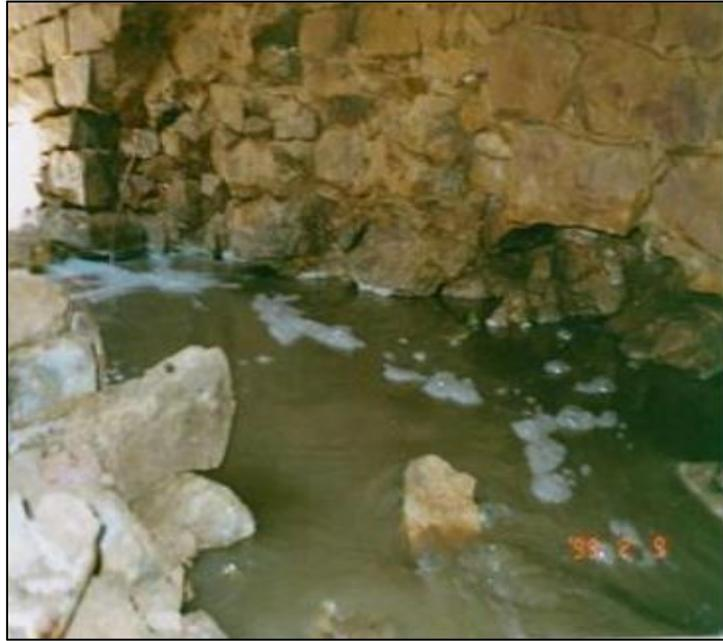
**Figure IV.8 :** décrochement des éléments de la maçonnerie, effondrement partiel au niveau des murs
