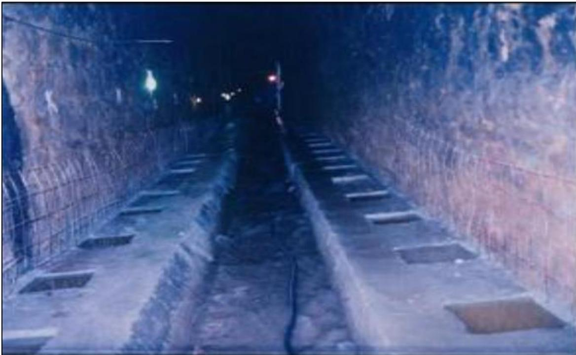
**Figure IV.15** :Radier réalisé pour une section en voute
