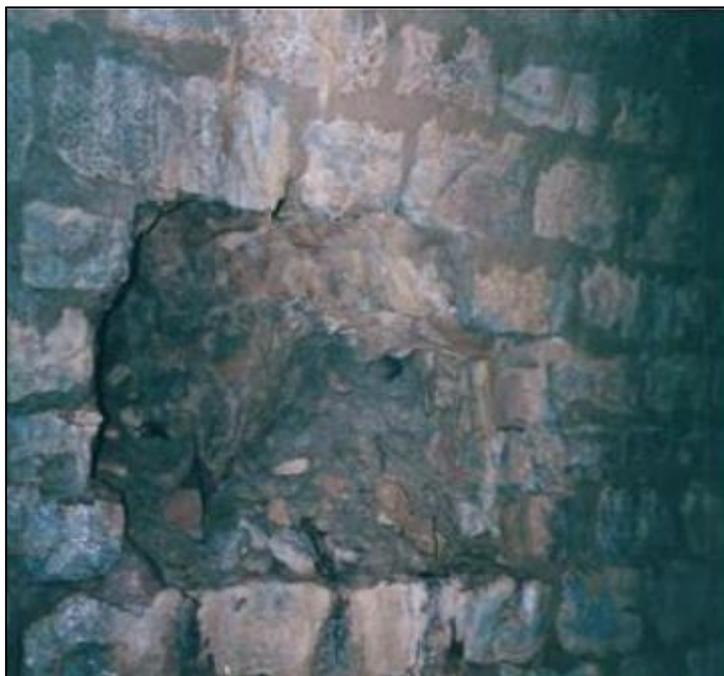
**Figure IV.11 :** Obturation des drains
