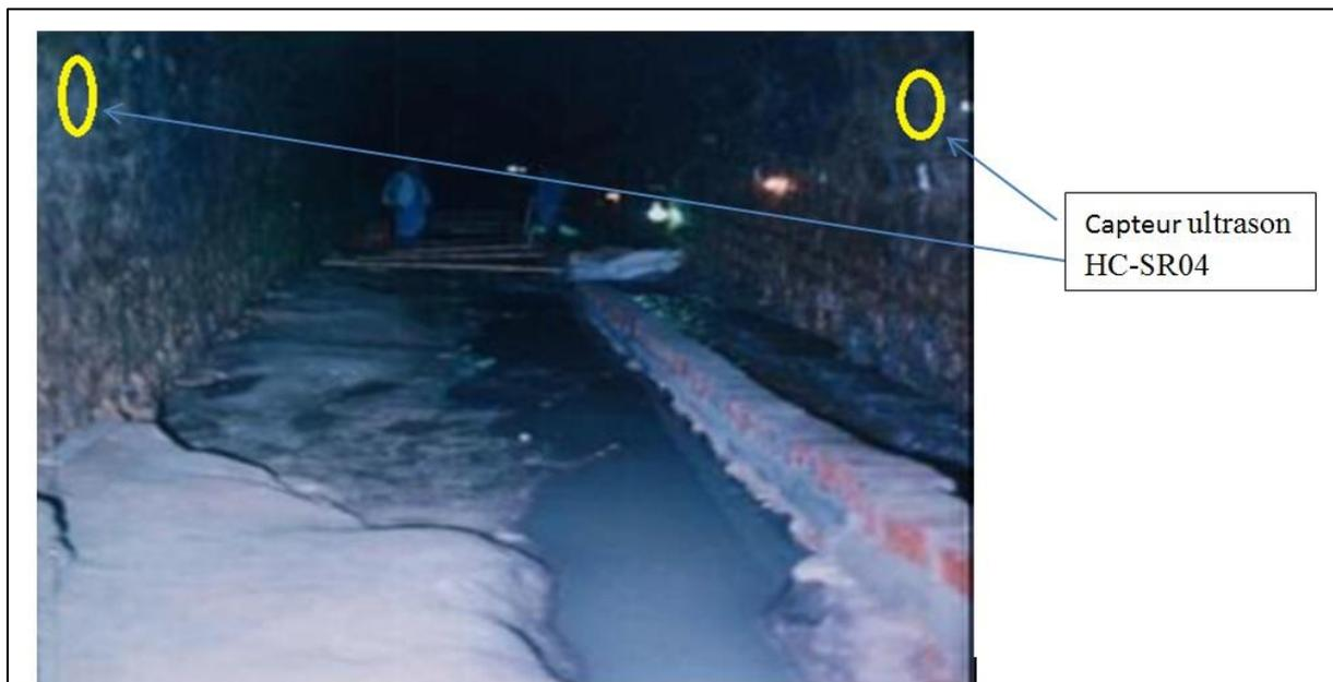
Figure V.20 :Exemple d'installation des capteurs à l'intérieur de canal de oued Tolba
