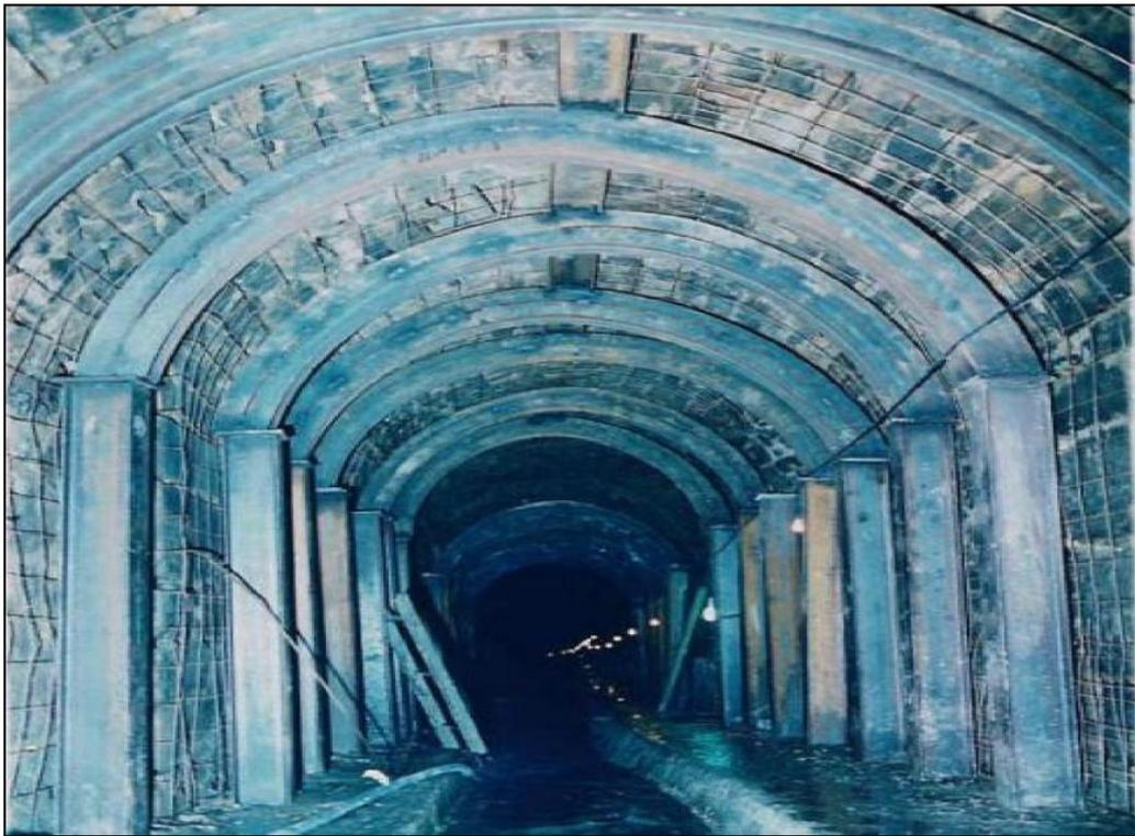
**Figure IV.17 :** Montage des éléments métalliques sur les murs et la voûte
