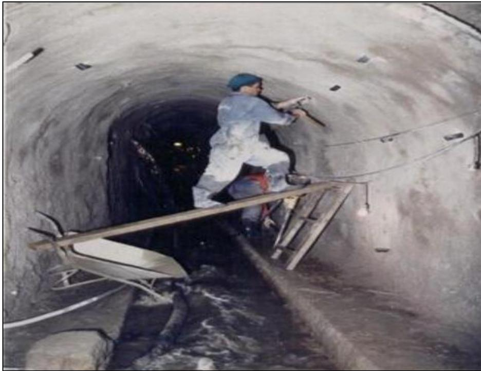
Figure IV.20 : Pré - achèvement de la projection du béton d'une voûte
