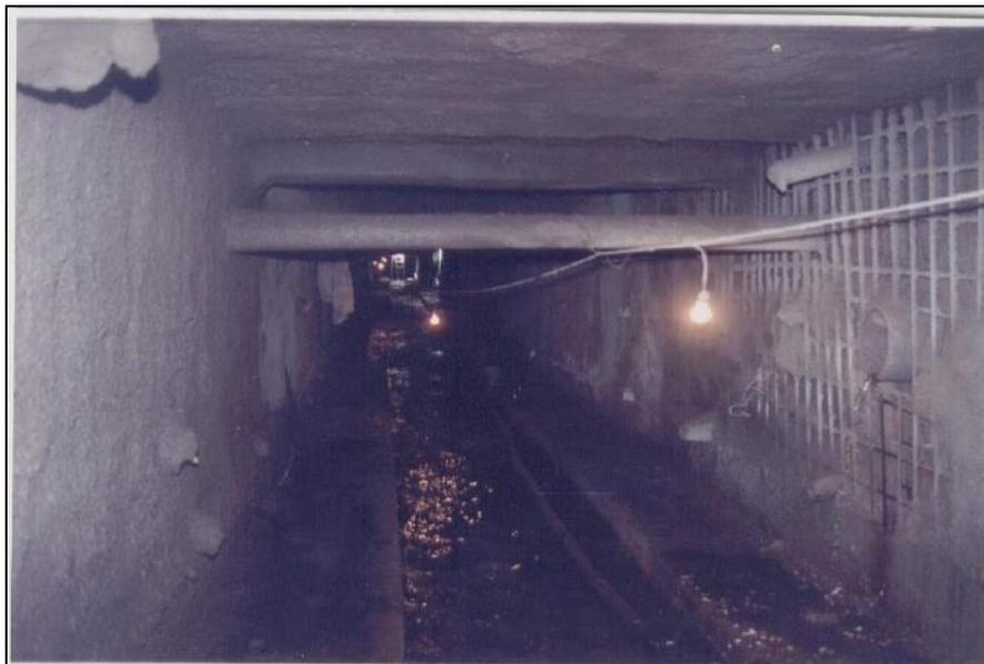
**Figure IV.19 :** Pré - achèvement de la projection du béton d'une section rectangulaire
