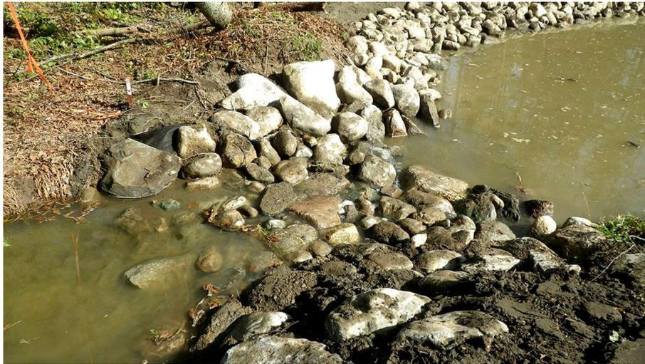
Figure V.14. Trappe de sédimentation
