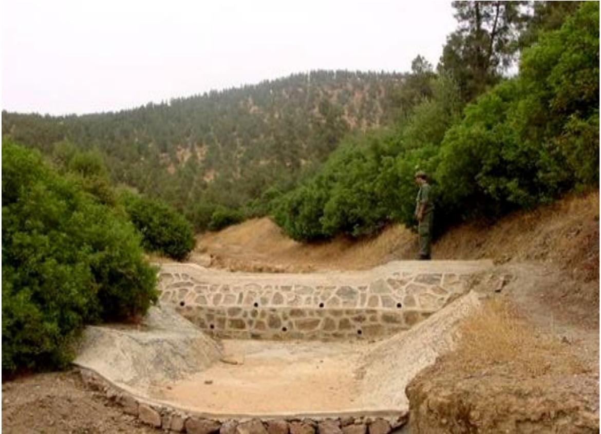
Figure III.3: Seuil en maçonnerie
