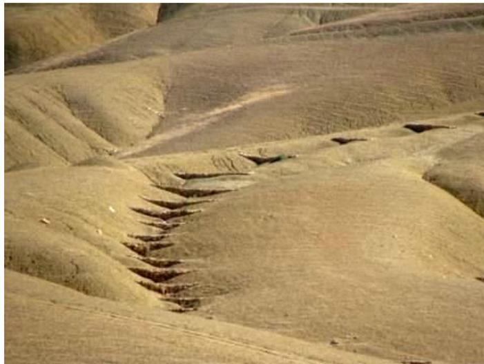
Figure IV.1. Une série de seuils réalisée sur une ravine du bassin versant de Beni Chougarne (cliché. Remini, 2014)
