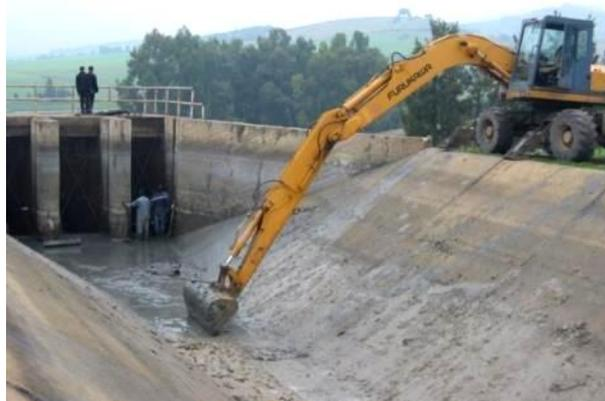
Figure II.9 : Curage d'un canal par les moyens mécaniques (Cliché. OPIM, 2008)
