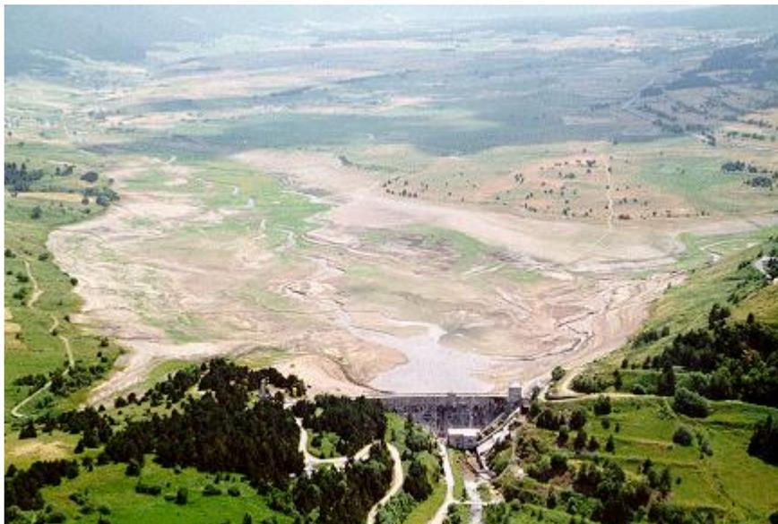
Figure II.1: Envasement d'une retenue
