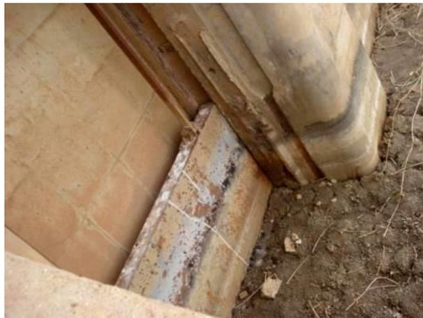
Figure II.8 : Blocage de la vanne de fond de la deuxième digue du barrage Boughezoul (cliché. Remini, 2011)
