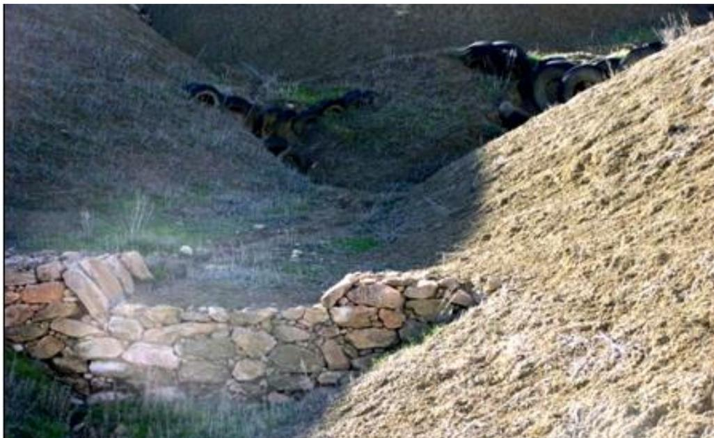
Figure V.10 : En premier plan un seuil en pierres sèches puis plus loin un autre seuil en pneu inondés par les atterrissements.
