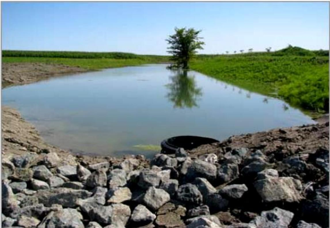
Figure V.11 : Image d'un bassin de décantation.
