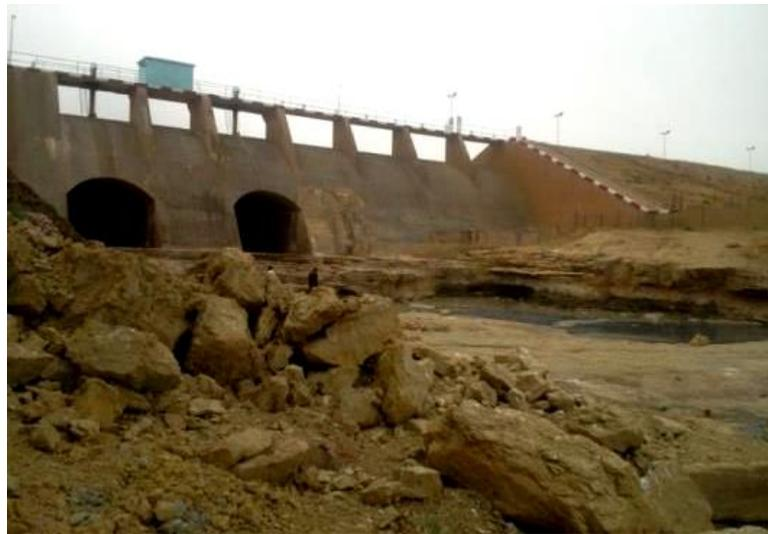
Figure IV.4 : Deux vannes de fond du barrage de Boughezoul (Cliché. Remini, 2011)
