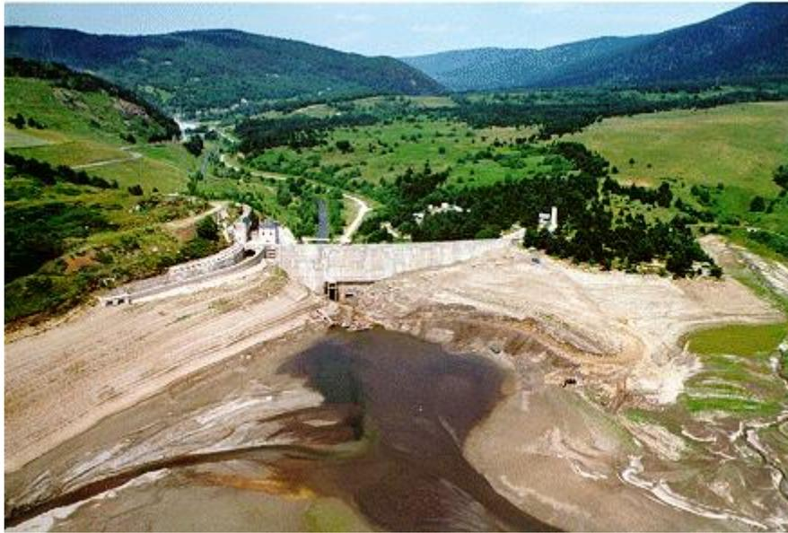
Figure II.2: Envasement d'une retenue
