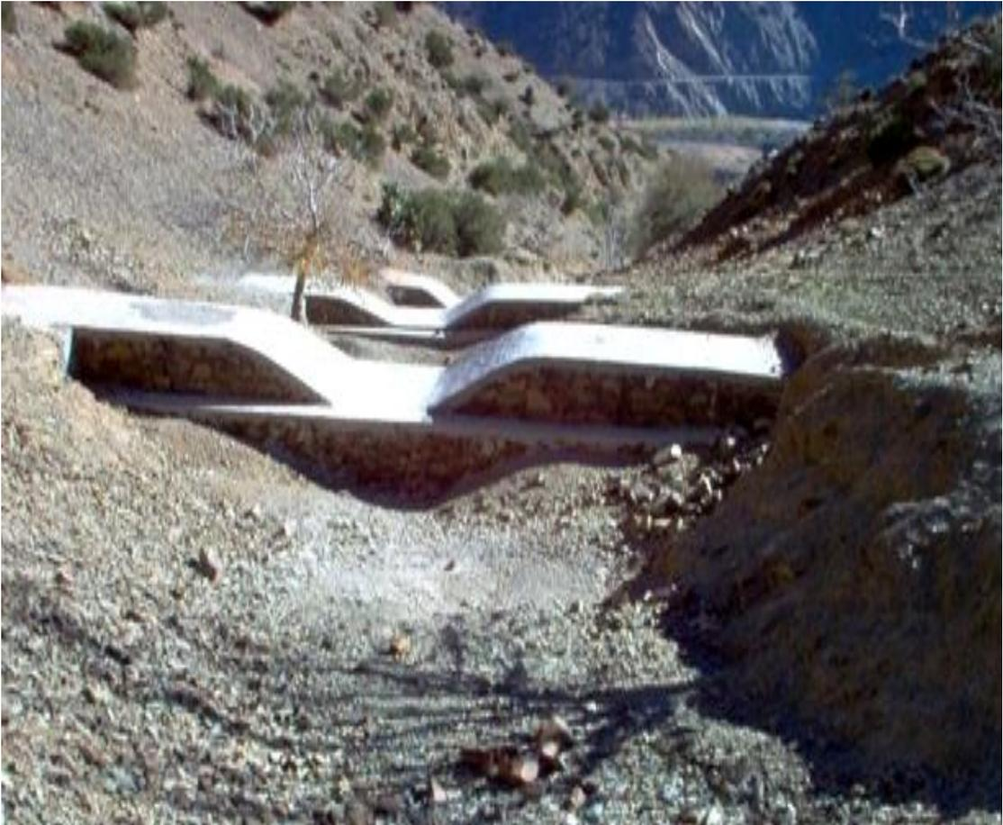
Figure III.2. Seuil en gabion
