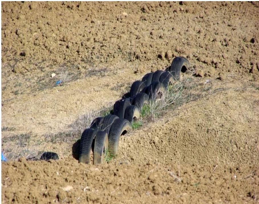
Figure V.8 : Seuil en pneu
