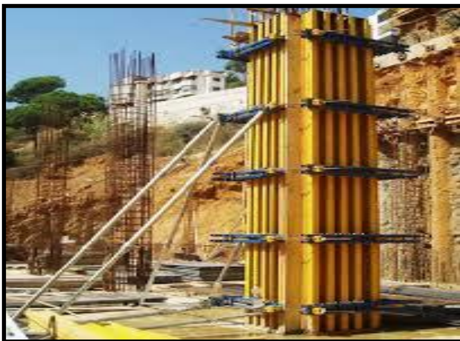
Figure I . 17: coffrage en bois
