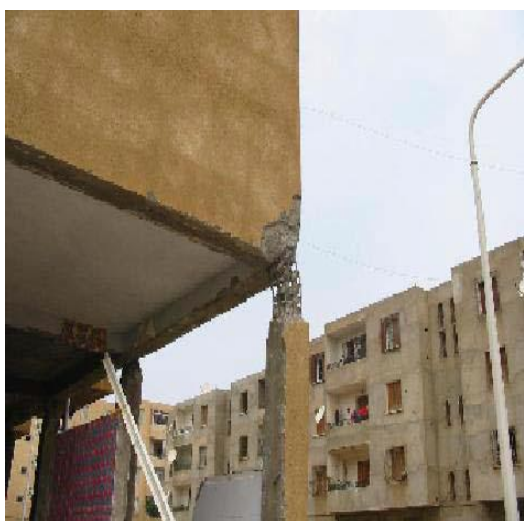
Figure I .21: Effet du séisme sur les poteaux(BOUMERDAS 2003)
