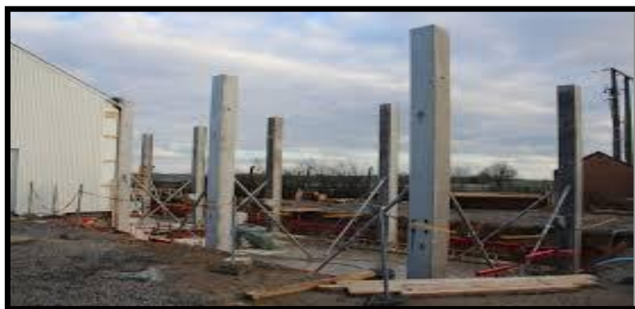
Figure I .2 : Poteaux en béton armé
