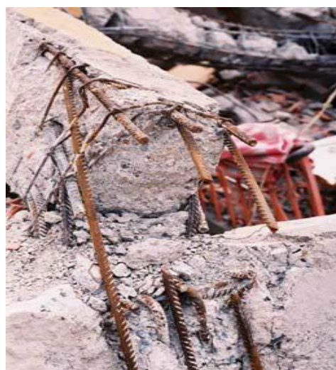
Figure I .21: Effet du séisme sur les poteaux(BOUMERDAS 2003)
