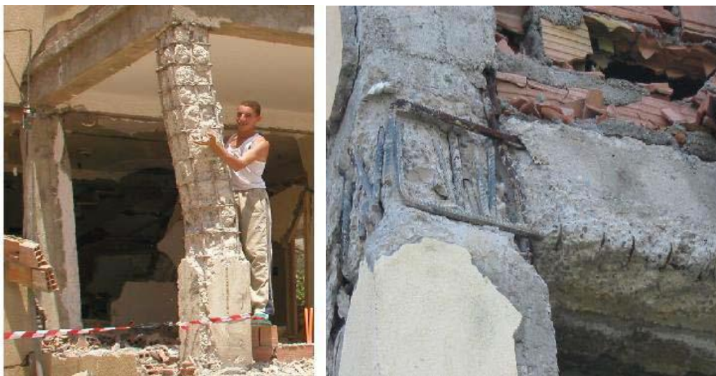
Figure I .22 : l'effet de l'absence des cadres dans les poteaux
