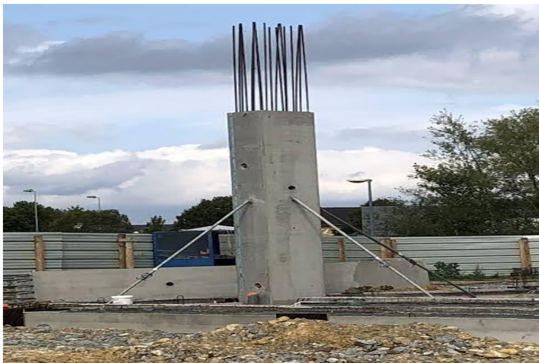
Figure. I.10 : poteaux en béton armé.
