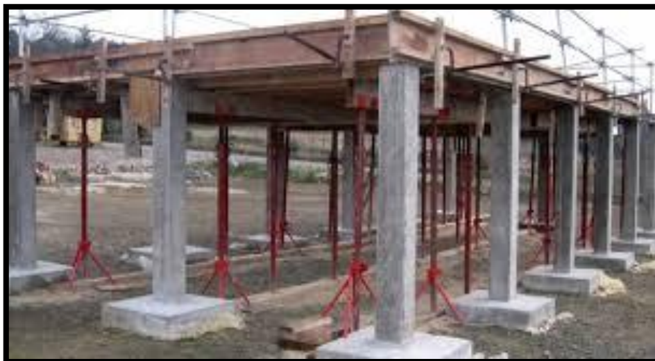
Figure I .1 : Pose de poteaux en béton armé
