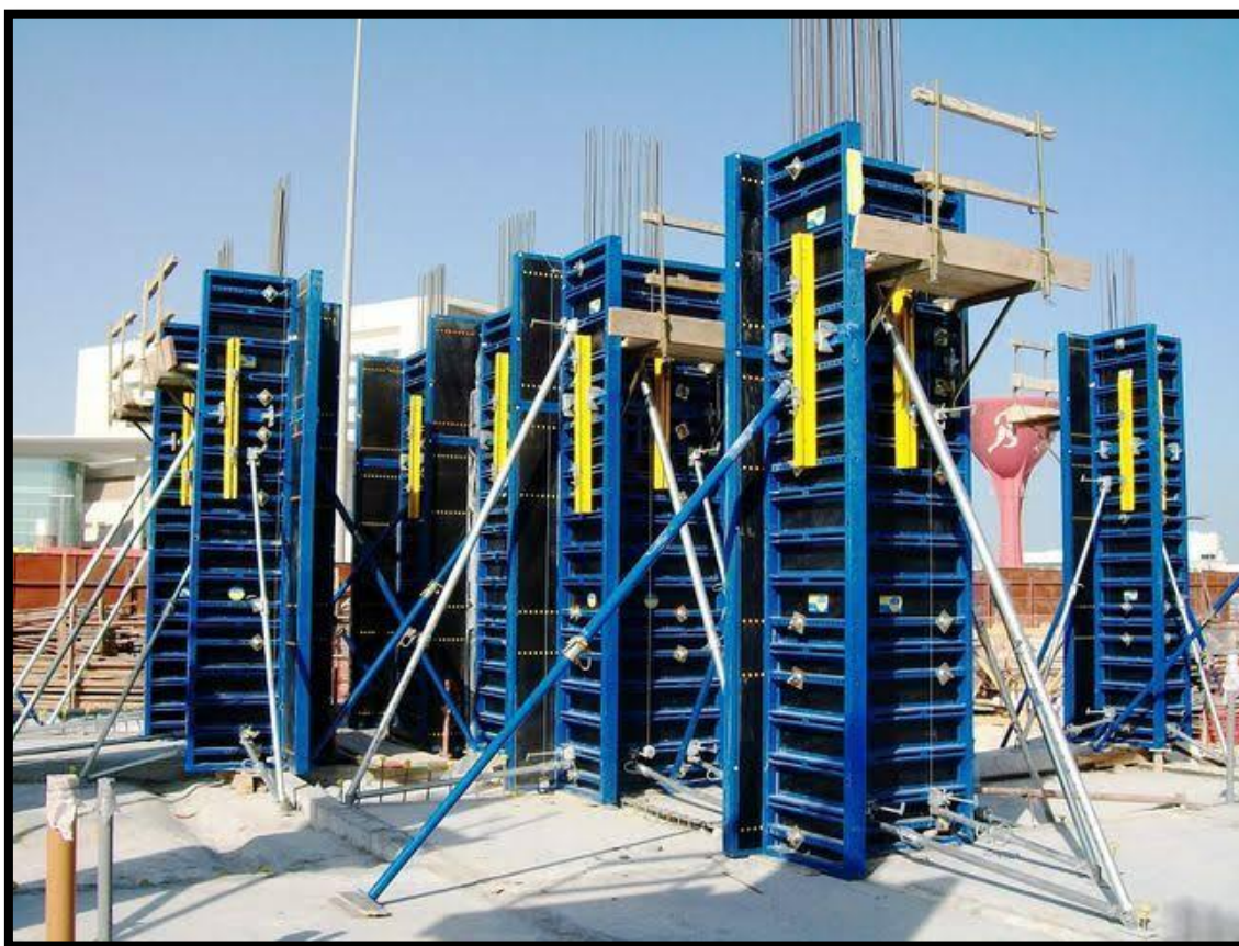
Figure. I .19 : coffrage du poteau en métal
