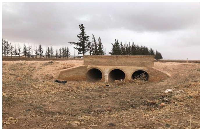
Figure V.2 : Ouvrage d'Assainissement en bon état nécessitant un curage
