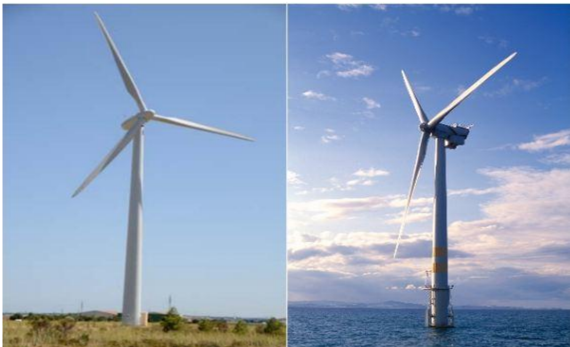
Figure 1.17 : Éolienne à axe horizontal.
