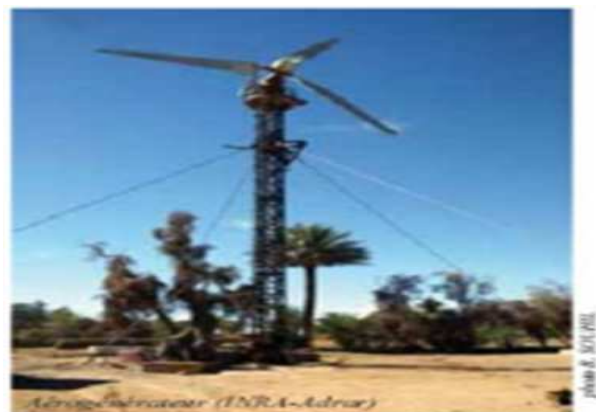
FIGURE 1.4 – Photo d'une première éolienne installée en Algérie [25].
