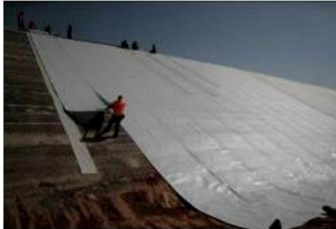
Figure I.8 : Pose de géomembrane (Barrage de Sar Cheshmeh, Iran)
