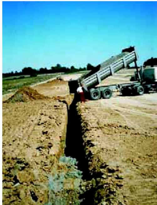
Figure III.9 : Drain vertical creusé dans le remblai et remplissage par du sable drainant et autofiltrant
