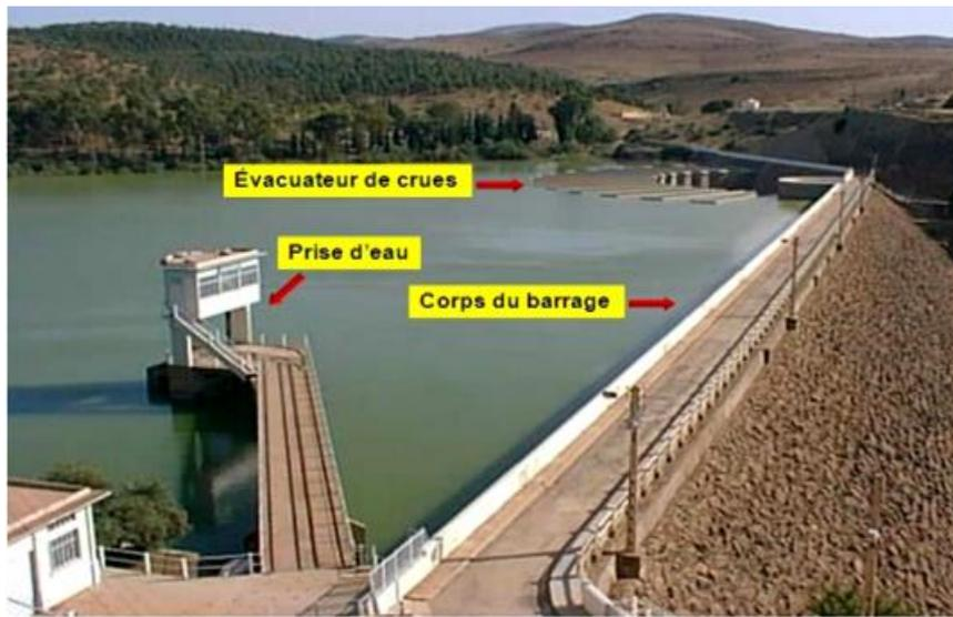
Figure I.2 : Eléments constructifs d'un barrage.
