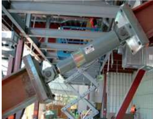
Figure 1: dissipateur d'énergie à fluide visqueux placé diagonalement.
