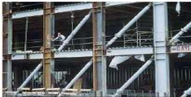
Figure 1.11 : utilisation des amortisseurs en diagonale dans les bâtiments
