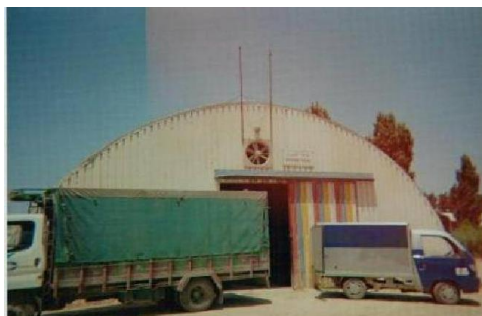
Figure13 : chambre de refroidissement
