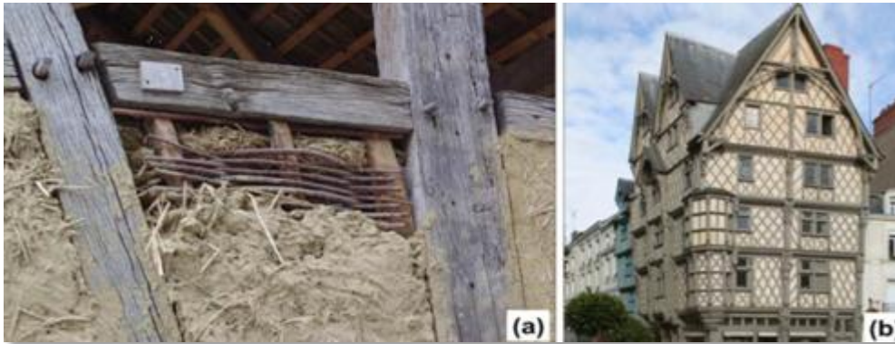
Figure I.7 : (a) La technique du torchis illustrée ; (b) Une construction en torchis à Angers, France
