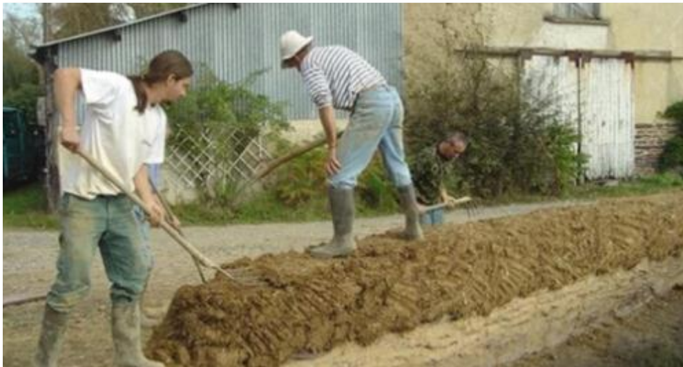
Figure I.10 : Construction d'un mur en terre crue avec la technique de la bauge.
