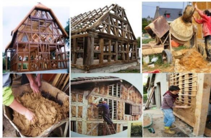
Figure I. 8: techniques de construction en torchis alsace France.
