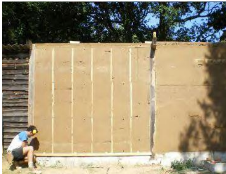
Figure 1.12 : La terre coulée, un béton de terre
