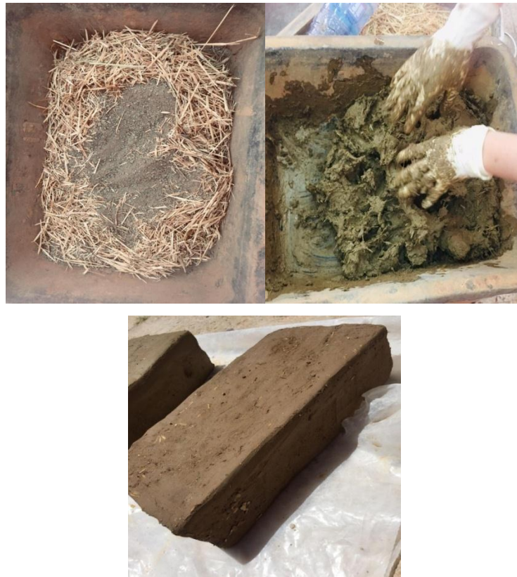
Figure IV. 33: Mode opératoire de fabrication des adobes
