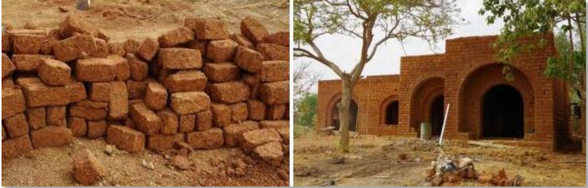
Figure I.11 : Construction en blocs découpés, Burkina Faso
